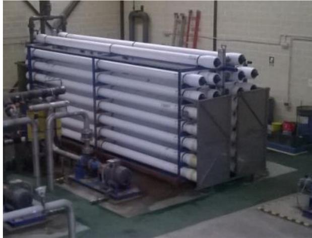
**Imagen 49. Membrana SW30XLE-400i (izq.) y ejemplo de un bastidor de ósmosis inversa (der.)**
