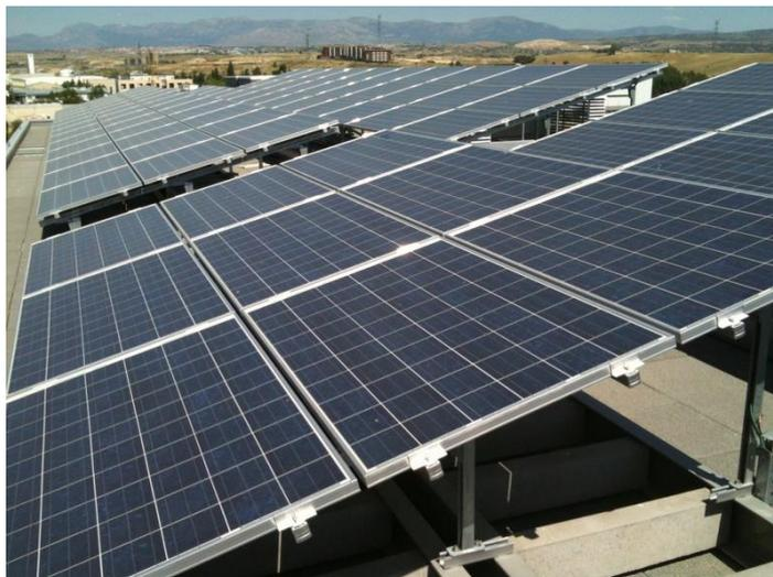
**Imagen 56. Campo solar de paneles fotovoltaicos**
