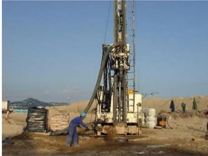
**Imagen 46. Construcción de un pozo de captación**
