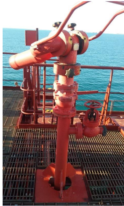
Ilustración 7; Cañon de cubierta. Fuente; Trabajo de campo.
