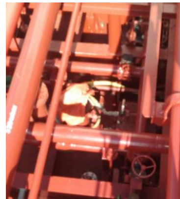
Ilustración 18; Sonda del tanque. Fuente; Trabajo de campo.
