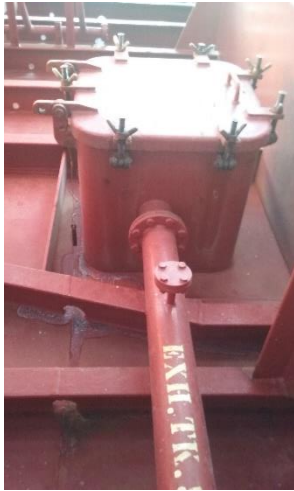
Ilustración 27; Tapa pequeña del tanque. Fuente; Trabajo de campo.
