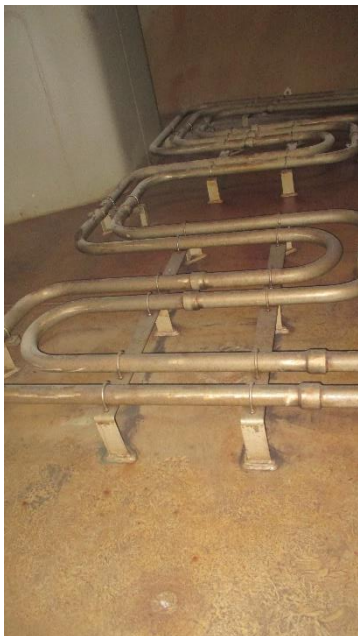
Ilustración 24; Serpentes de calefacción. Fuente; Trabajo de campo.
