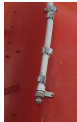
Ilustración 3; Rociador del bote de caída libre. Fuente; Trabajo de campo.
