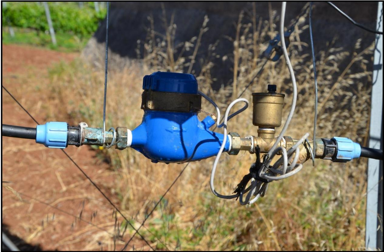
**Foto 34: Detalle del contador instalado junto a un purgador de aire.**
