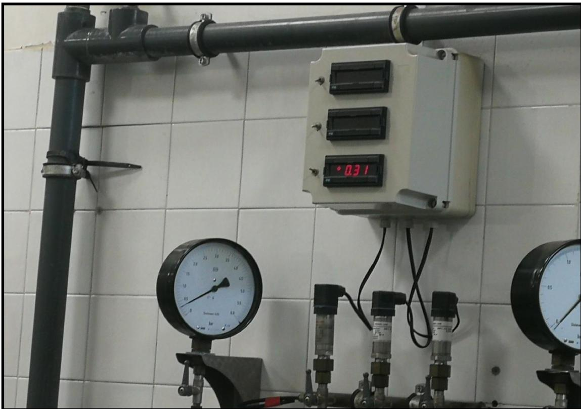
**Foto 17: Transductores de presión y manómetros Bourdon.**
