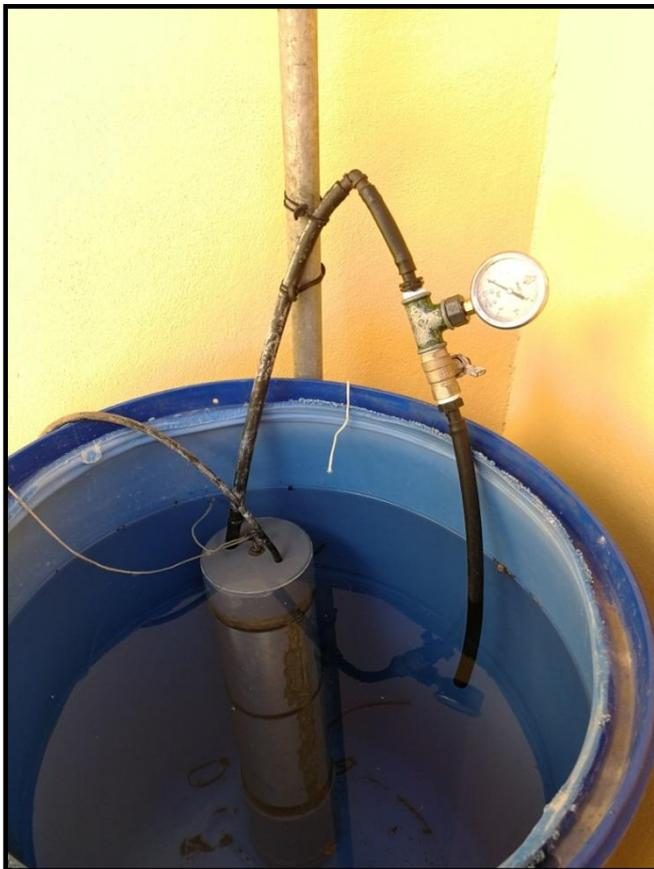
Foto 22: Conjunto filtro, bomba, manómetro y válvula
