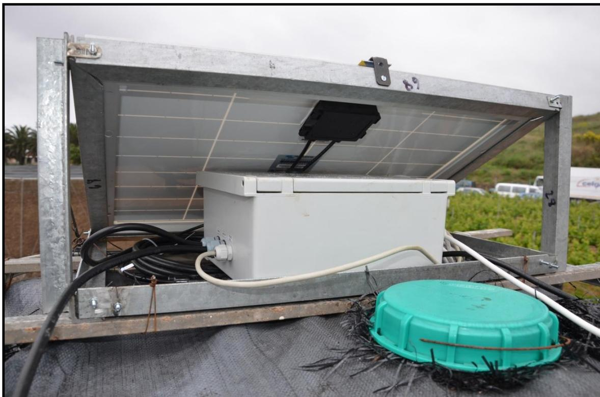
**Foto 33: Detalle de panel solar y armario estanco.**
