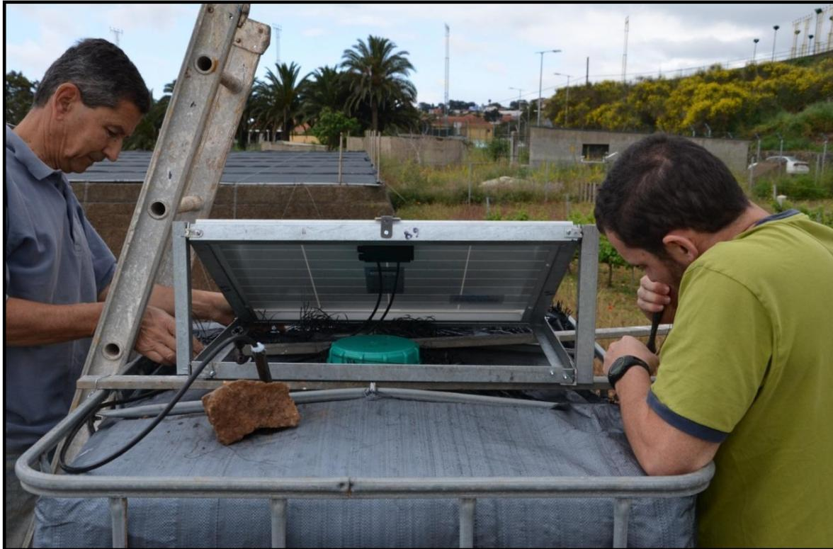
**Foto 32: Fijando el panel solar a la estructura del depósito.**
