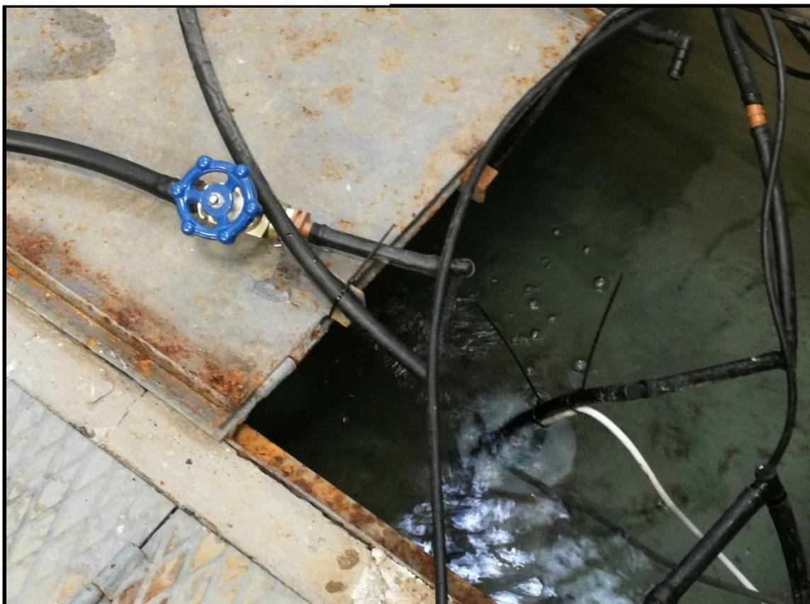
Foto 13: Válvula de aguja instalada en el retorno.
