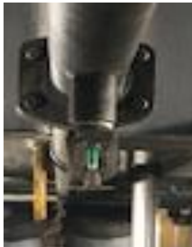
Imagen 15: Rociador de ampolla verde Fuente: Trabajo de campo
