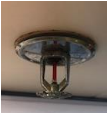
Imagen 7: Rociador de ampolla roja Fuente: Trabajo de campo
