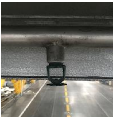
Imagen 10: Rociador de garaje sin ampolla Fuente: Trabajo de campo
