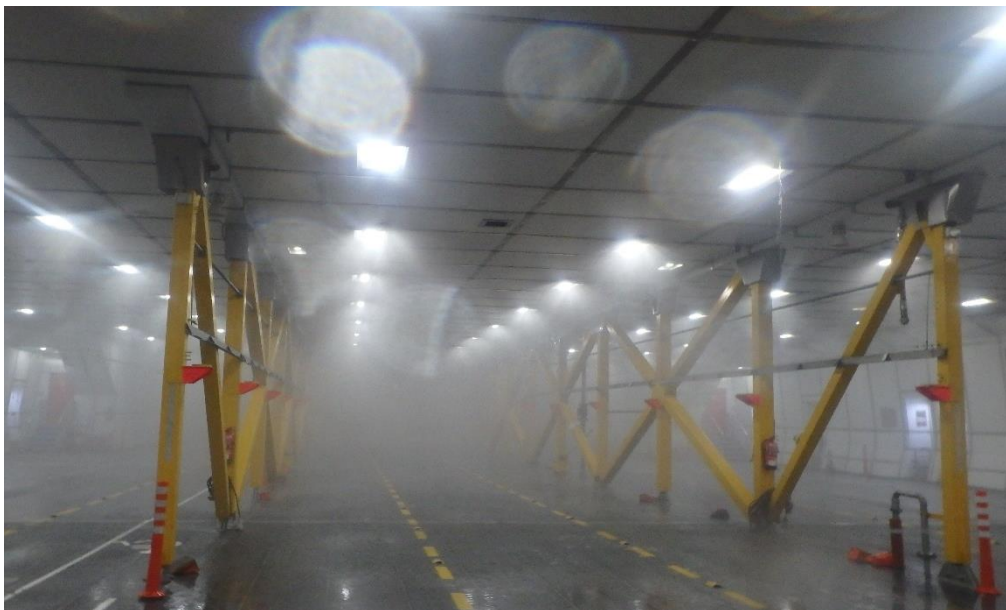
Imagen 14: Prueba de rociadores de garaje Fuente: Trabajo de campo
