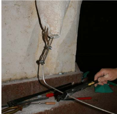
Imagen 25.- Realización del armazón mediante acero inoxidable, latón y hierro.
