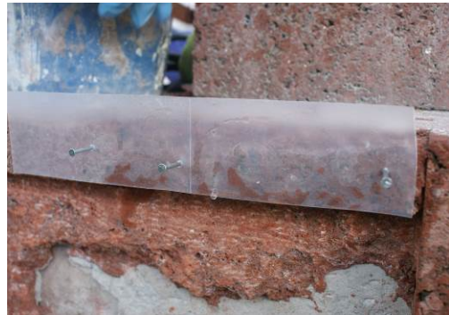
Imagen 35.- Encofrado realizado para la reconstrucción del perfil superior izquierdo de la base.
