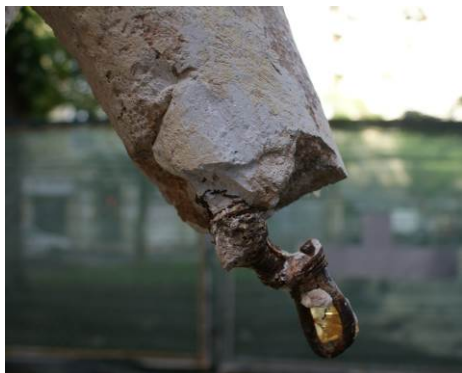
Imagen 23. - Restos de hierro, alambres y resina de la reposición anterior.
