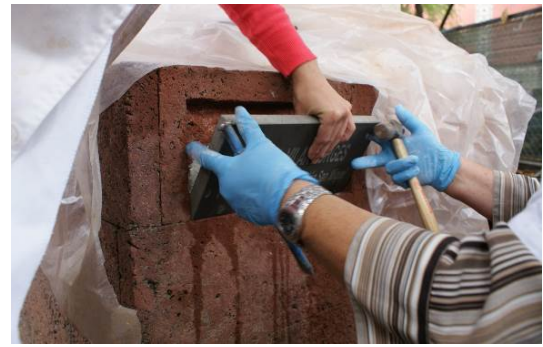
Imagen 43. Colocación de la placa.
