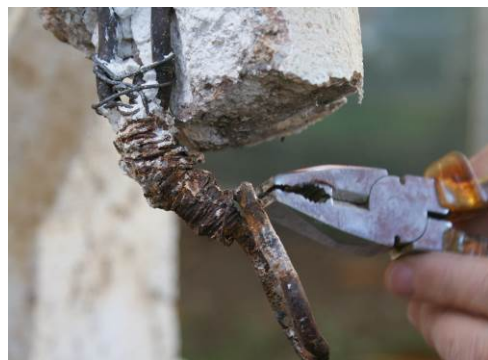
Imagen 24. - Eliminación de los materiales originales que presentan un avanzado estado de deterioro.
