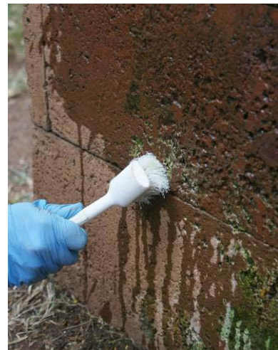
Imagen 33. - Eliminación en profundidad del moho mediante limpieza en húmedo.
