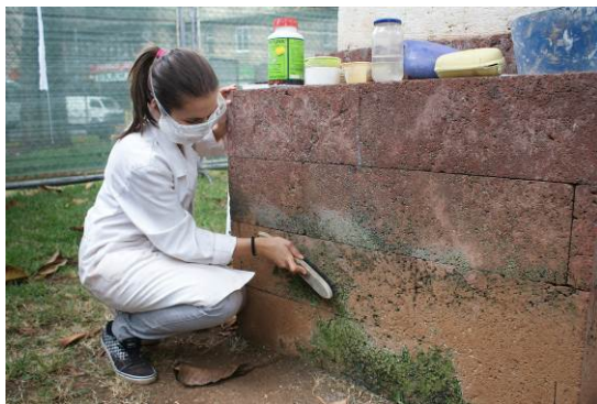
Imagen 32. - Eliminación superficial del moho en seco.
