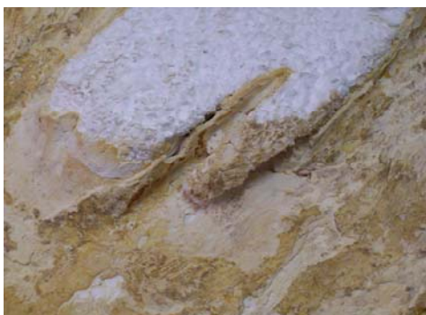
Imagen 3.- Como se observa en las imágenes, sobre el corcho blanco tallado se aplicó estuco de cal.
