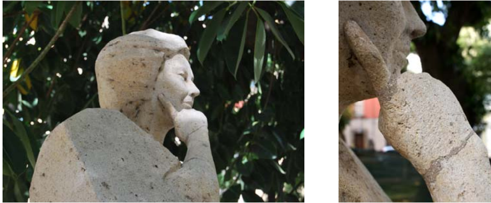
Imagen 10. - Detalle de reposiciones de roturas en cemento y elementos calcáreos derivados del proceso de ejecución.
