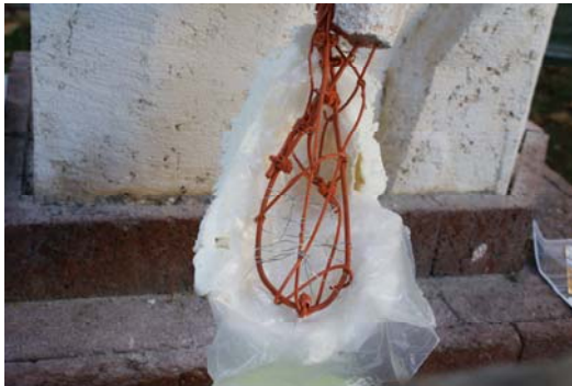
Imagen 26.- Detalle del nuevo armazón (protegido con pintura antióxido) y la cama de espuma de poliuretano.
