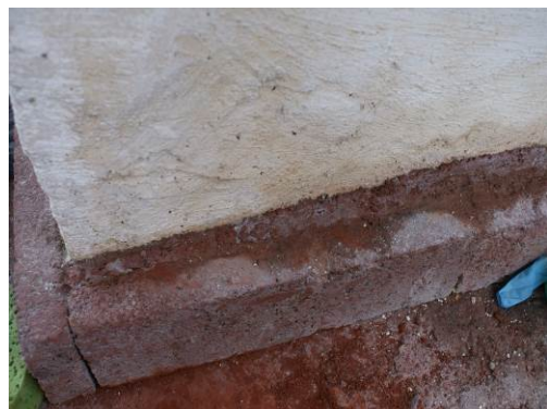
Imagen 37.- Nivelado de juntas con la misma mezcla.
