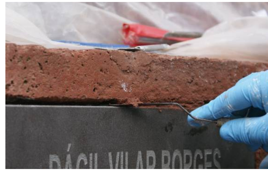
Imagen 45. Detalle del relleno de juntas
