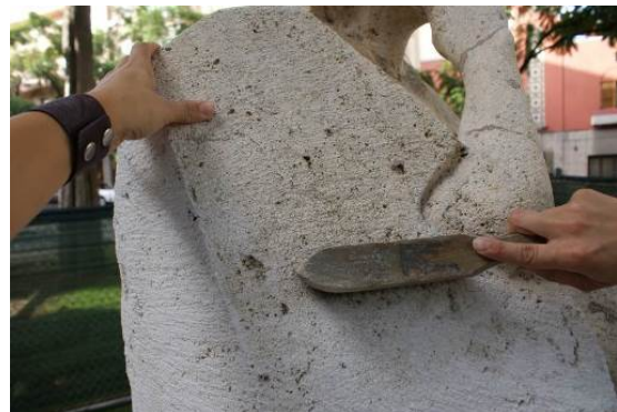
Imagen 17. - Detalle de limpieza con cepillo metálico.
