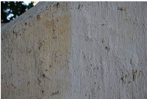
Imagen 16. Limpieza de la superficie con cepillo de cerdas plásticas.
