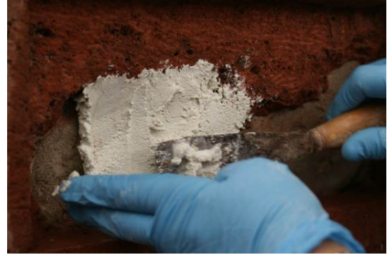
Imagen 41. Detalle de la mezcla aplicada para el asiento de la placa.
