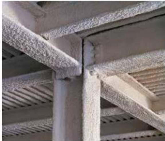
Ilustración 14. Protección pasiva elementos estructurales mediante mortero proyectado. Fuente propia.
