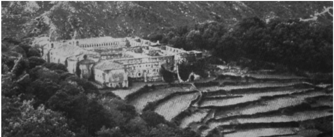
Fig. 1: Vista general del monasterio de Santo Estevo, ca.1963.
