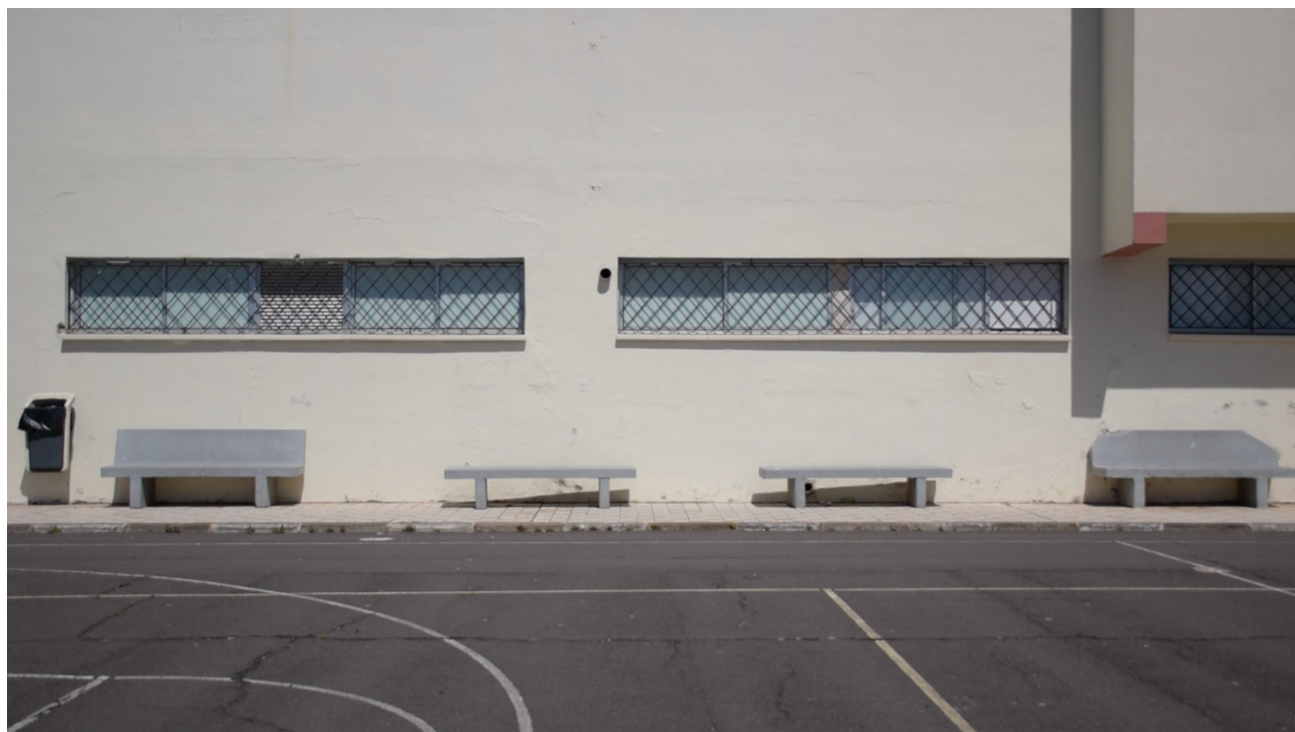
Figura 16. El espacio es amplio pero condicionado por las líneas dibujadas en el suelo y los elementos que se interponen correspondientes a los deportes de pelota: fútbol, voleibol y baloncesto. El mobiliario que existe es de hormigón y está fijado al suelo, imposibles de ser desplazados. Fuente: Jezabel Mejías
