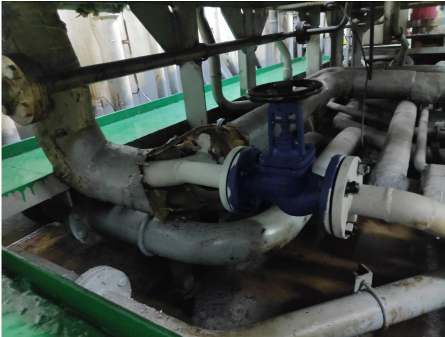
Ilustración 34: Modificación aspiración bomba de combustible de la depuradora
