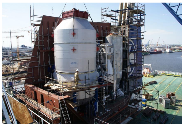
Ilustración 2: “Instalación de una Torre de lavado en un buque tipo ro-ro”
