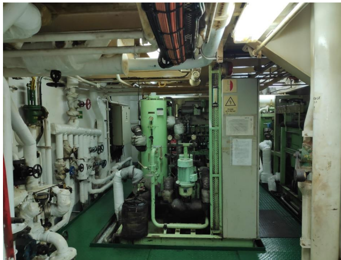
Ilustración 13: “Módulo de combustible”
