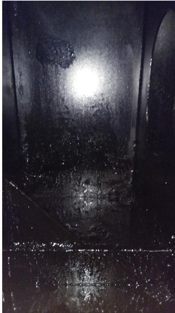
Ilustración 29: Interior tanque de combustible
