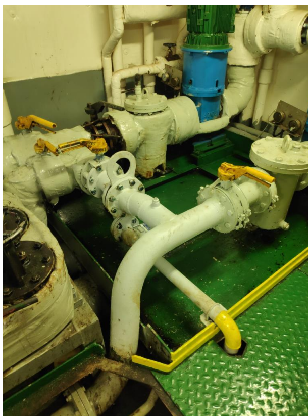
Ilustración 33: Línea trasiego con modificación.
