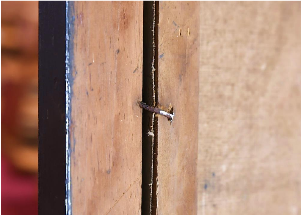
Fig. 73: Clavo oxidado y saliente que sujeta el marco con el lado izquierdo del bastidor
