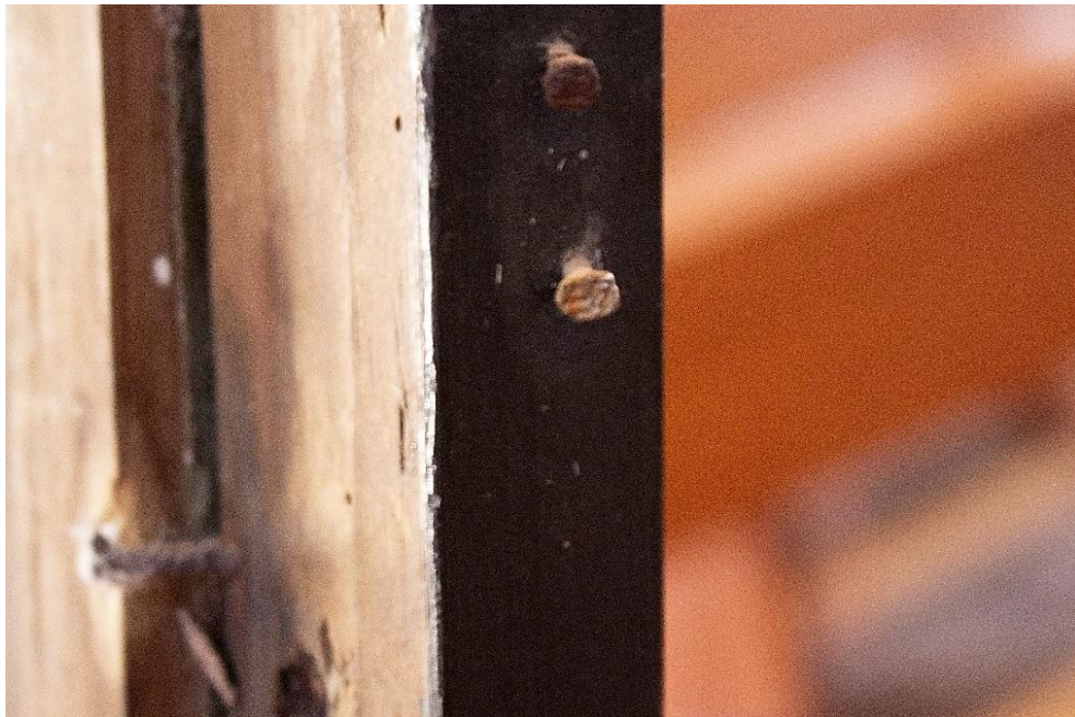
Fig. 89: Clavos salientes y oxidados del lateral derecho del marco
