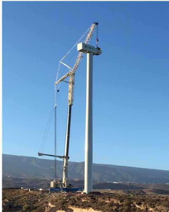
Figura 2: Montaje de aerogenerador GAMESA G-114, con tres hélices, disposición onshore, para el parque eólico Chimiche II (IBERDROLA, 2018)
