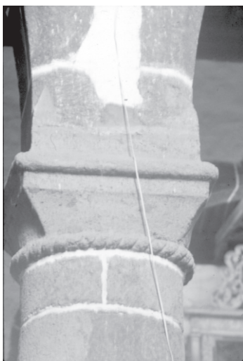
3- Capitel de las naves.
