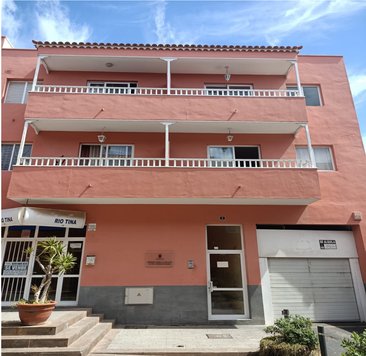
Figura 3: Casa del que se hace la instalación eléctrica
