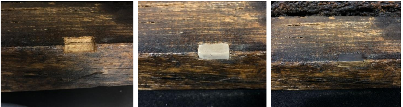
Ilustración 95. Falta volumétrica, resina aplicada y reintegración cromática
