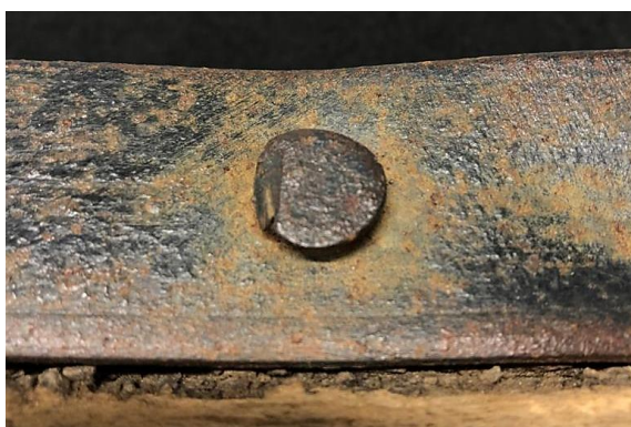
Ilustración 62. Tornillos de remache
