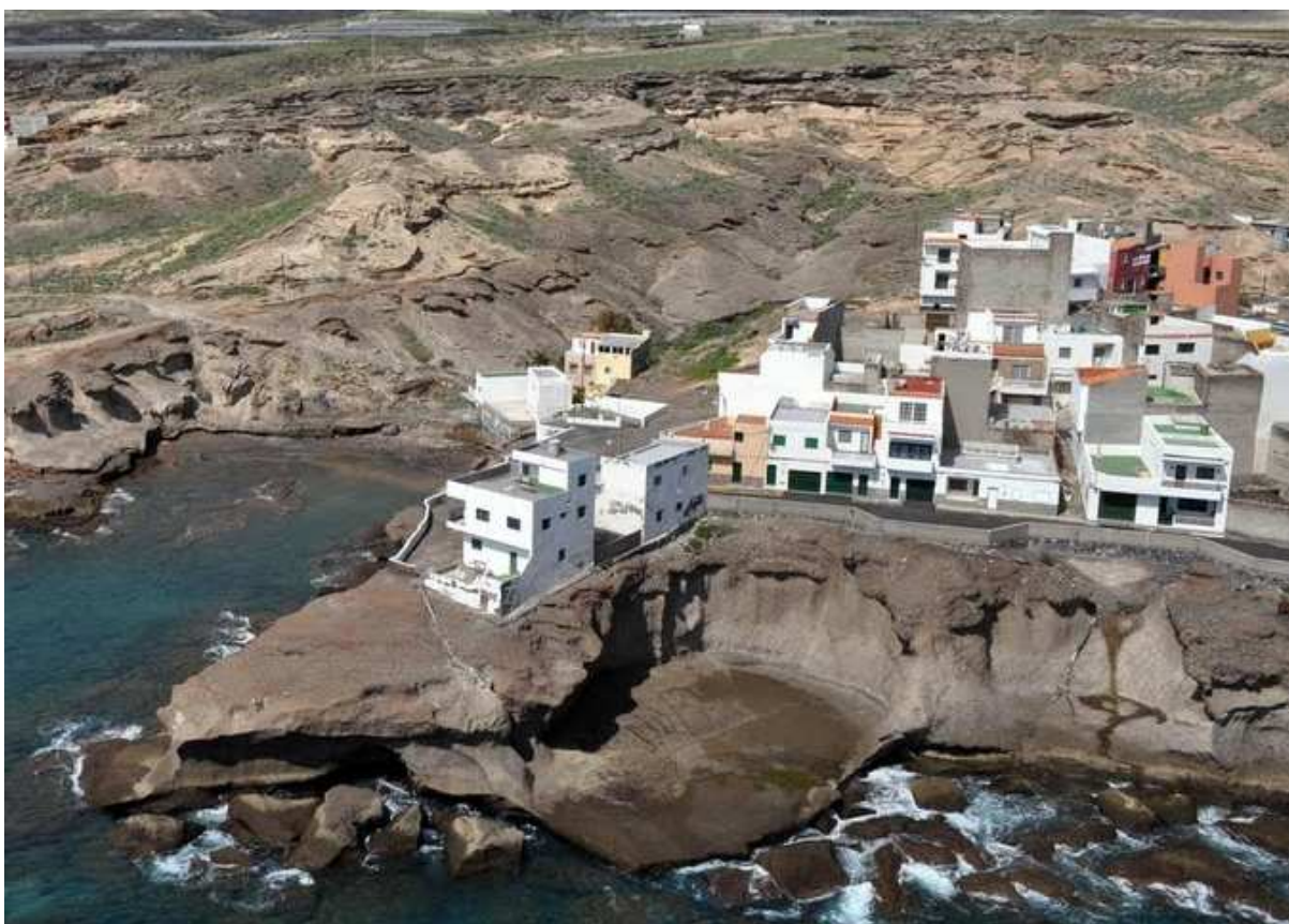
Figura nº V-68. Asentamiento espontáneo de La Caleta, en el litoral suroeste de Arico. Se observa la estructuración urbanística de la parte suroeste del pequeño núcleo costero y como algunas de edificaciones invaden impunemente el espacio de servidumbre marítimo-terrestre. Recuperado de www.fotosaereasdecanarias.com/
