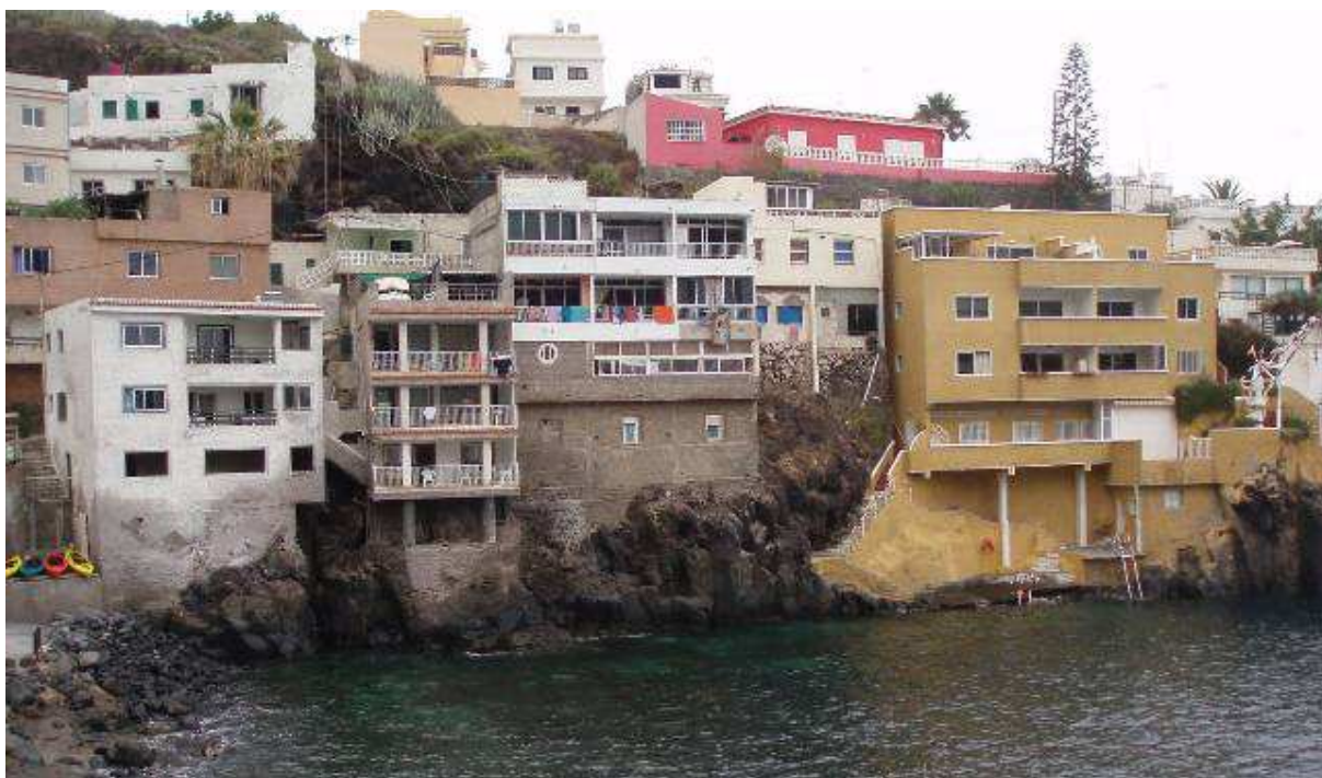
Figura nº V-39. El Caletón es un pequeño núcleo costero de nueva planta situado en La Matanza de Acentejo donde el impacto de la urbanización espontánea resulta evidente. Recuperado de www.fotosaereasdecanarias.com/
