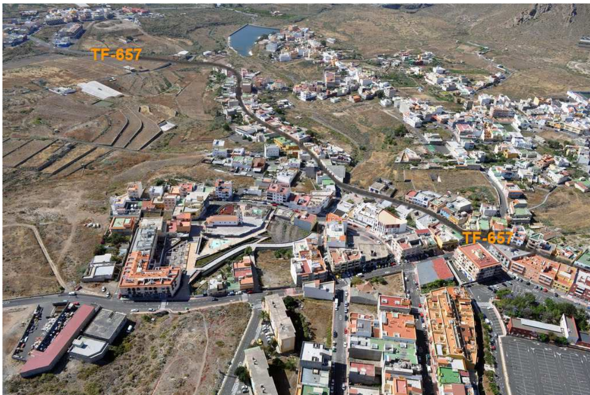
Figura nº V-99. Vista parcial del núcleo principal de Cabo Blanco del municipio de Arona, con la señalización de la traza de la TF-657, de Buzanada a La Camella. La trama urbana espontánea de la urbanización de Los Llanos-El Morro, queda visualizada en la parte superior derecha de la imagen. Recuperado de www.fotosaereasdecanarias.com/
