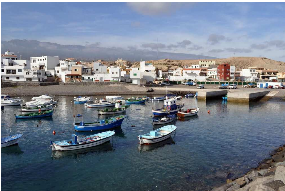
Figura nº V-67. Asentamiento espontáneo de La Mareta en el litoral suroeste de Arico. Se aprecia el desorden urbanístico del frente costero del núcleo y como parte de las edificaciones abordan el espacio de servidumbre marítimo-terrestre. Recuperado de www.fotosaereasdecanarias.com/
