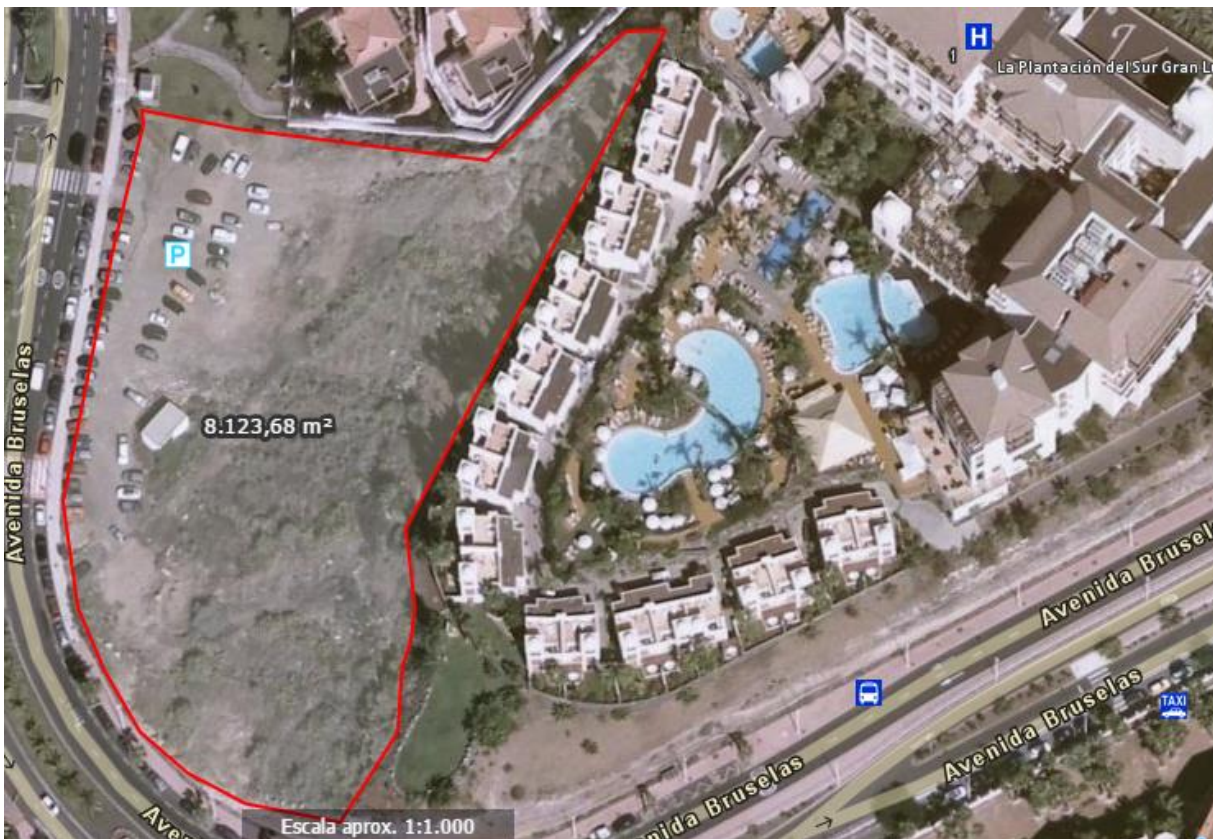
Ilustración 12. Terreno sin edificar para la instalación de placas [4]
