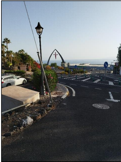
Ilustración 1. Acceso Depósito San Francisco a través de carretera TF-47 (1).
