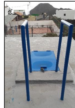
Ilustración 12. Compuerta sobreelevada.
