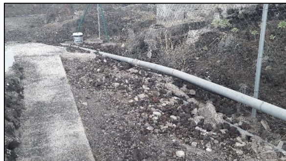
Ilustración 6. Pavimento perimetral de hormigón.
