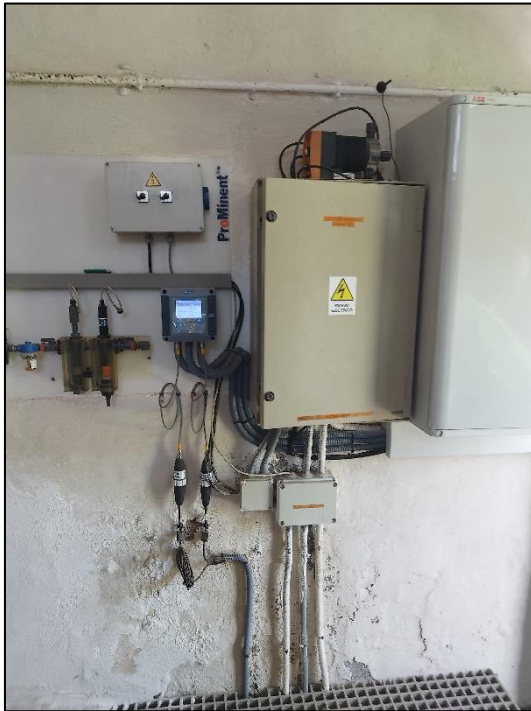
Ilustración 17. Display control parámetros del agua.
