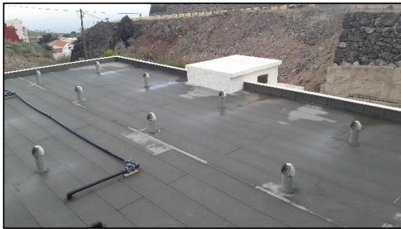
Ilustración 22. Impermeabilización con malla asfáltica.
