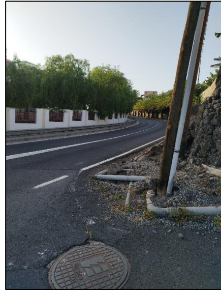
Ilustración 2. Acceso depósito San Francisco a través de carretera TF-47 (2).
