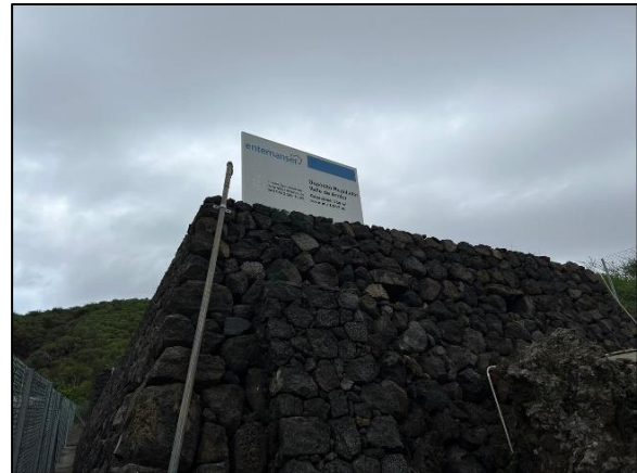
Ilustración 3. Exterior del depósito.
