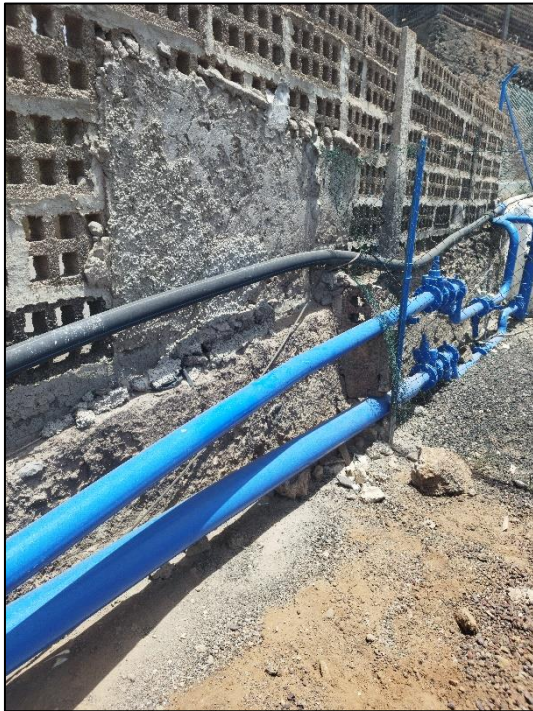
Ilustración 9. Conducción entrada Depósito Hoya Las Piedras 2 inferior (arriba) y conducción en desuso (abajo).
