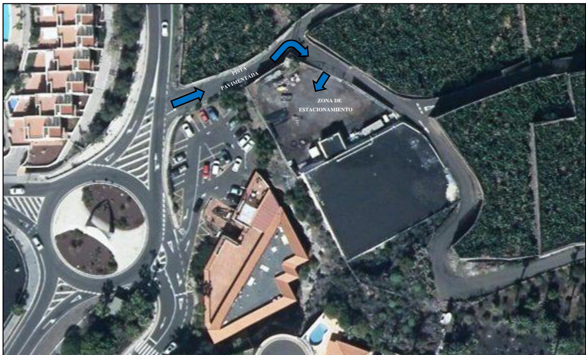
Ilustración 1. Acceso al Depósito San Francisco. Fuente: GRAFCAN.
