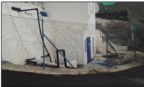
Ilustración 19. Vallado y cementado perimetral.
