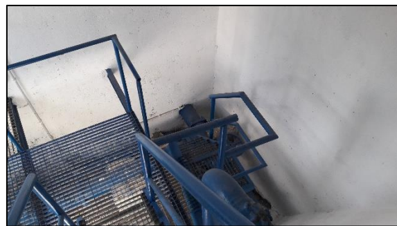
Ilustración 77. Trámex interior.
