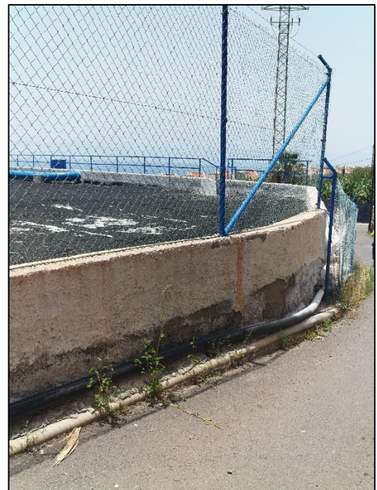
Ilustración 20. Exterior Depósito San Francisco.
