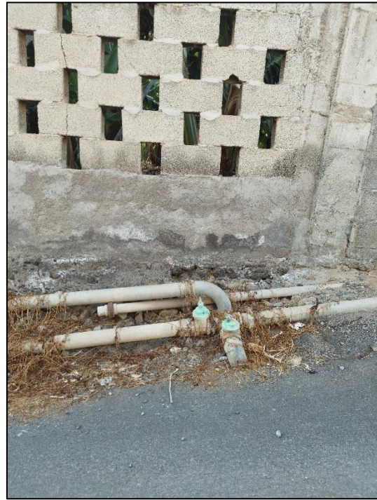
Ilustración 6. Entrada Depósito Hoya Las piedras 2.
