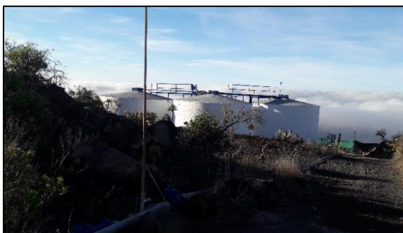
Ilustración 37. Techos con pendiente para evacuar el agua.
