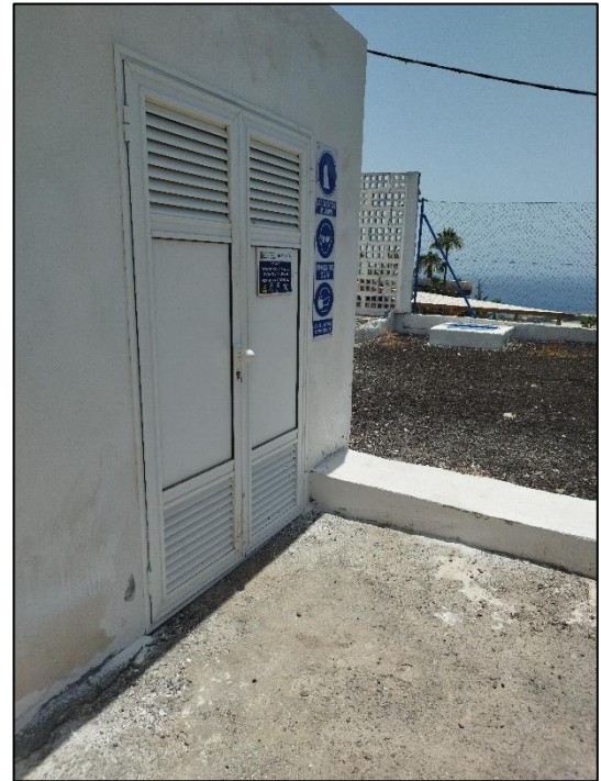
Ilustración 18. Exterior cuarto cloración.
