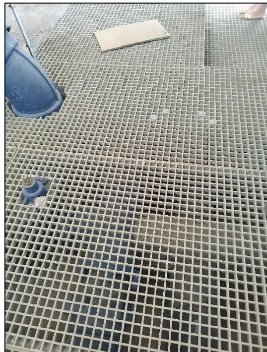
Ilustración 16. Salidas y desagües Depósito San Francisco.
