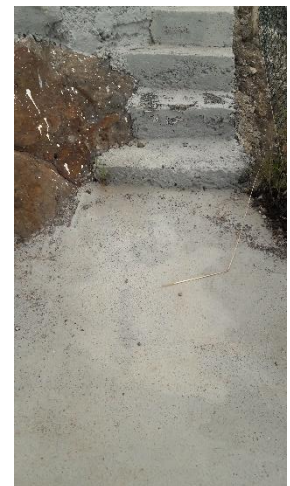
Ilustraciones 51 y 52. Pavimento perimetral de hormigón.
