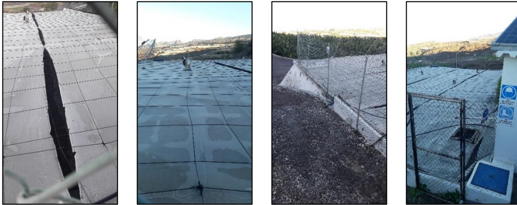
Ilustraciones 68,69,70 y 71. Techos y ventilación depósito.
