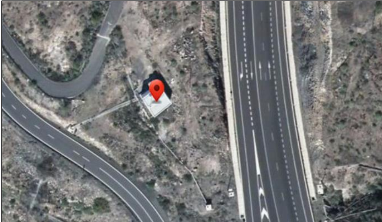
Ilustración 78. Ubicación Depósito Piedra Hincada. Fuente: GRAFCAN.
