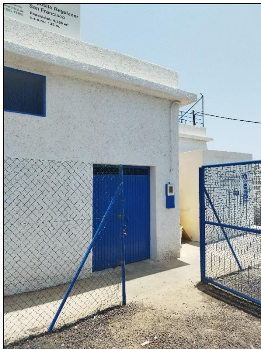
Ilustración 19. Exterior cámara de válvulas y cuarto de cloración.
