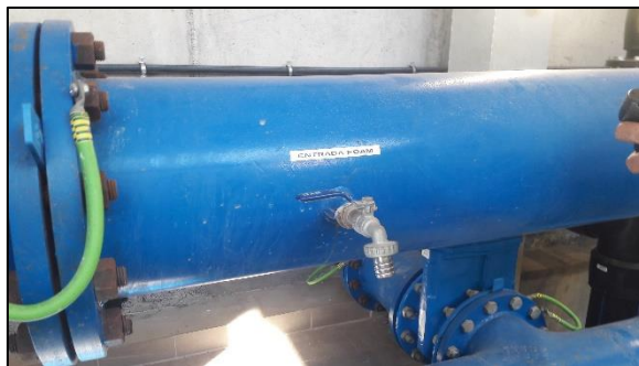
Ilustración 73. Toma de muestras a la salida de los vasos.
