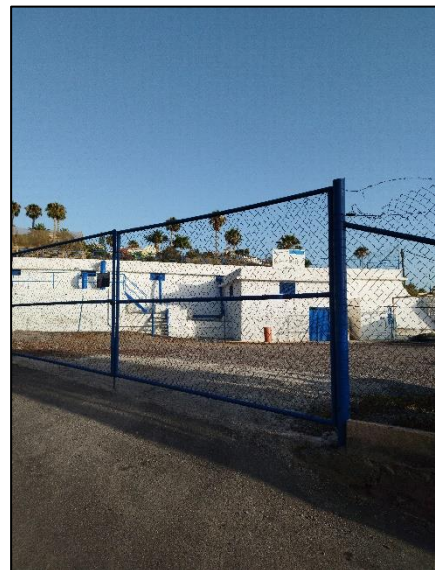
Ilustración 4. Entrada general Depósito San Francisco.
