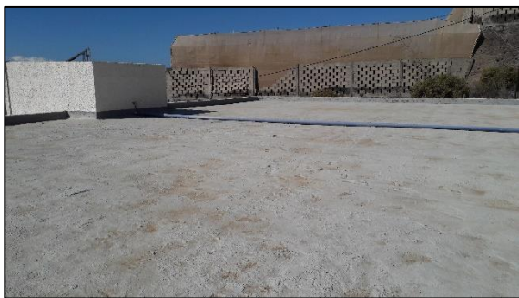
Ilustración 76. Impermeabilización con mortero de hormigón.
