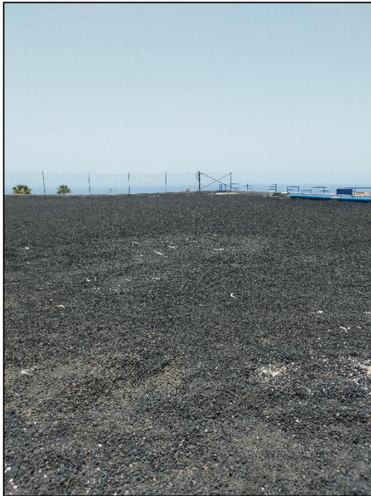
Ilustración 21. Forjado Depósito San Francisco.
