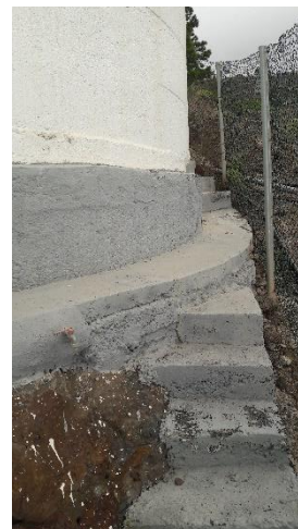
Ilustraciones 51 y 52. Pavimento perimetral de hormigón.
