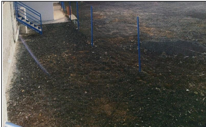
Ilustración 8. Capas granulares zona de estacionamiento.
