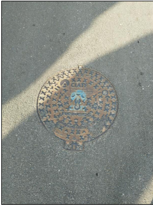
Ilustración 5. Alcantarilla CIATF, entrada EDAM Fonsalía.
