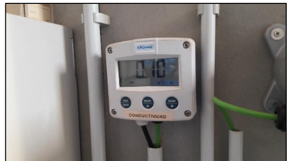
Ilustración 74. Medidor de conductividad en los vasos.
