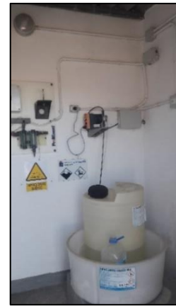
Ilustraciones 79,80 y 81. Ventilación, desagües y recipientes cuarto de cloración.
