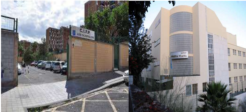
Figura 2. Acceso a las instalaciones
