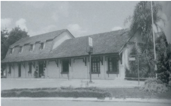
(c) Fachada norte.
