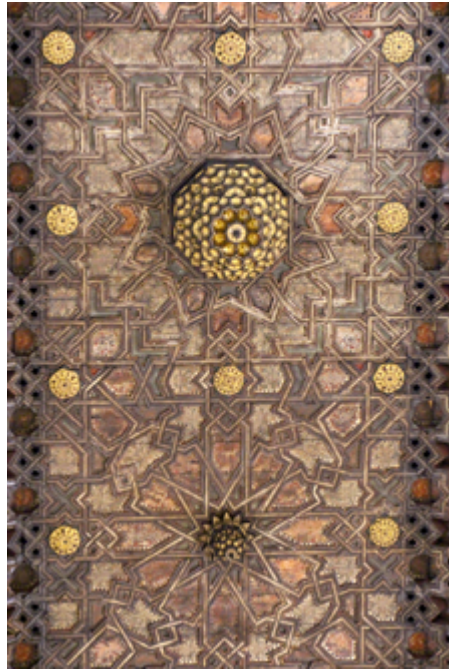
Figs. 11 y 12. Detalles de los almizates de la nave central de la iglesia de El Salvador y de la nave central de la catedral de Funchal. Observemos que, en ambos casos, el trabajo lacérico es muy similar, con una rueda de lazo de 12 y presencia de mocárabe y pinjantes. Foto del autor.
