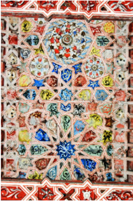
Figs. 11 y 12. Detalles de los almizates de la nave central de la iglesia de El Salvador y de la nave central de la catedral de Funchal. Observemos que, en ambos casos, el trabajo lacérico es muy similar, con una rueda de lazo de 12 y presencia de mocárabe y pinjantes. Foto del autor.
