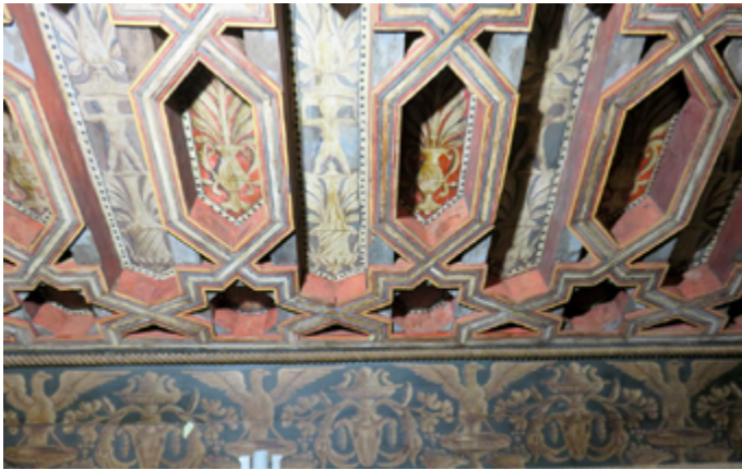
Fig. 19. Faldón y durmiente de las naves de la catedral de Funchal. Foto del autor.
