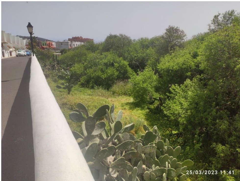
Imagen Nº4. Desnivel de terreno, Urbanización Mayber, Calle Oro del Risco.
