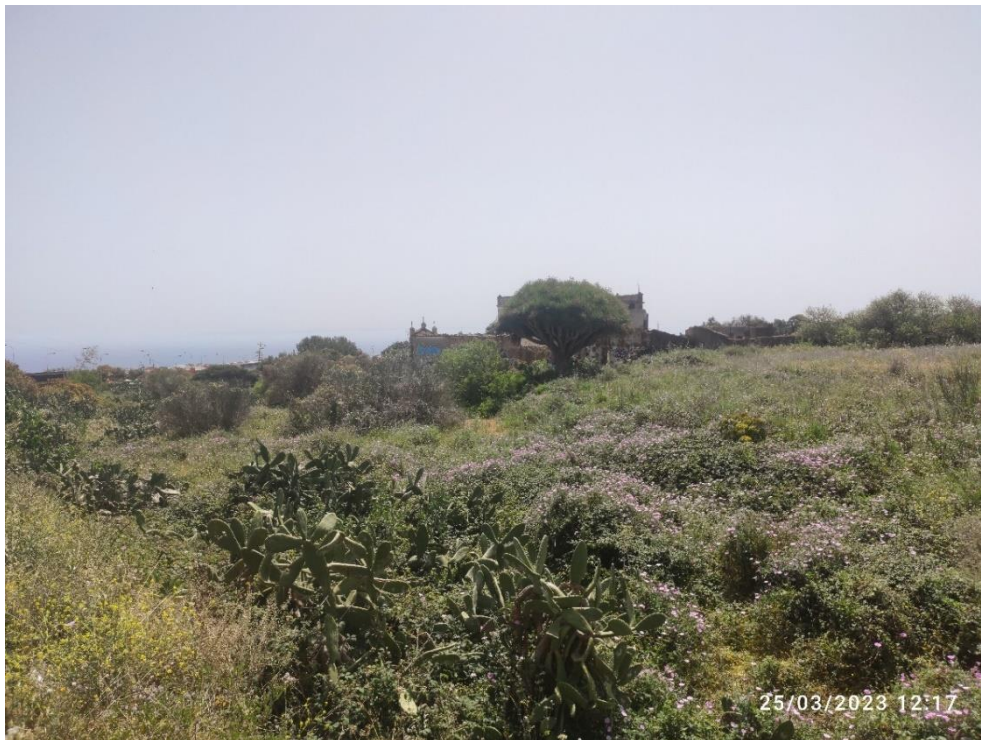
Imagen N°26. Edificación abandonada, Calle Mayber.
