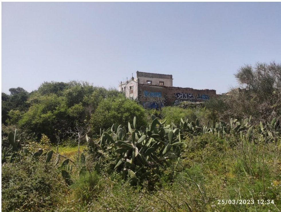
Imagen Nº29. Edificación abandonada, Camino San Bartolomé de Geneto.
