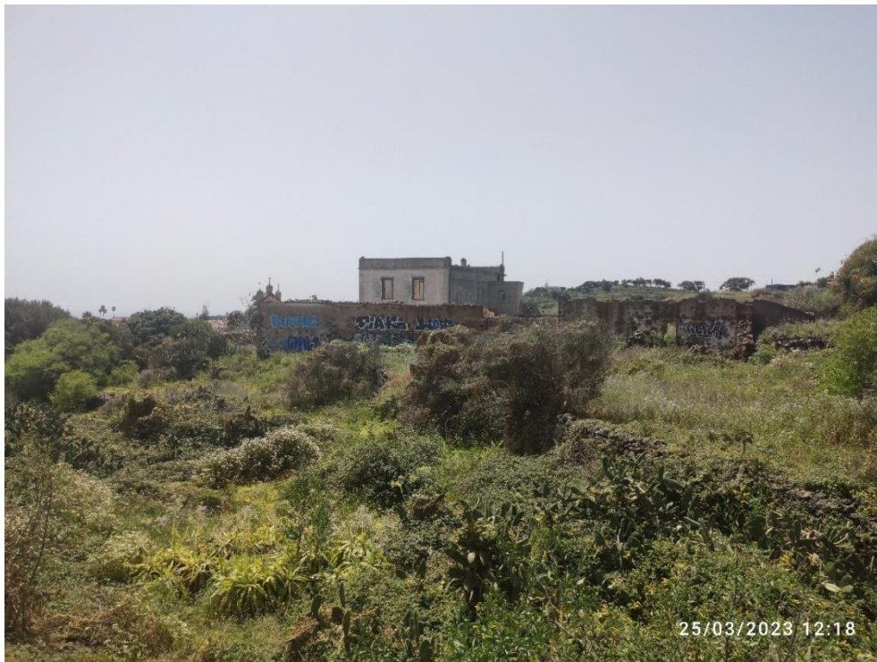
Imagen Nº28. Edificación abandonada, Camino San Bartolomé de Geneto.
