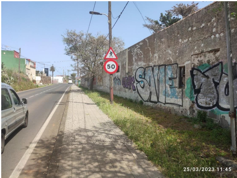
Imagen Nº8. Edificación abandonada, Camino San Miguel de Geneto.
