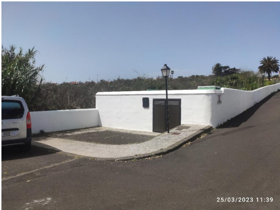
Imagen Nº2. Urbanización Mayber, Calle Oro del Risco.
