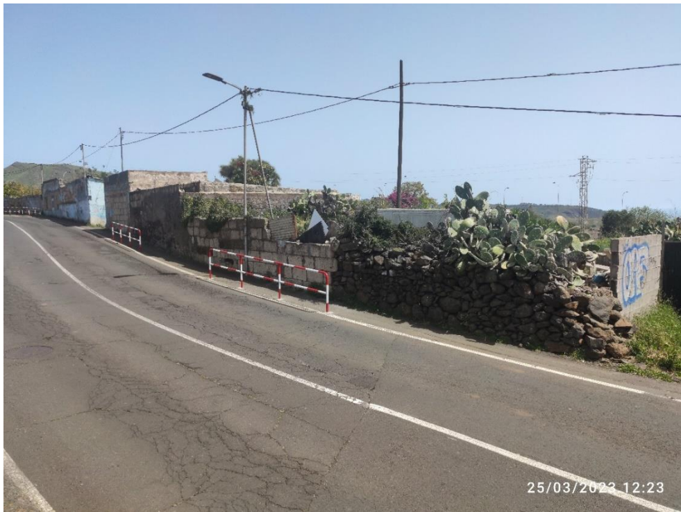
Imagen Nº34. Edificaciones abandonadas, Camino San Bartolomé de Geneto.
