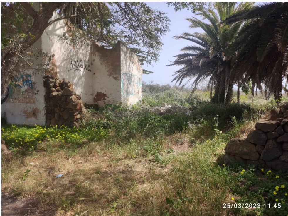
Imagen Nº9. Acceso a Edificación abandonada, Camino San Miguel de Geneto.
