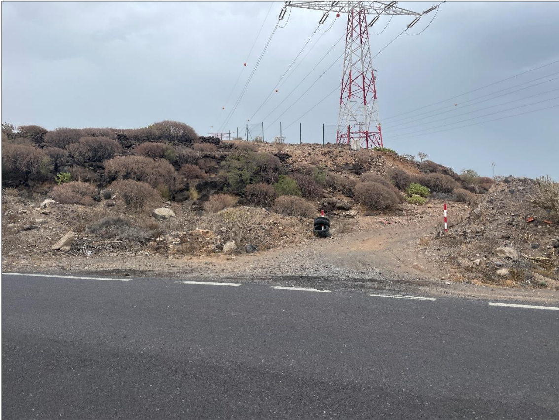
Imagen II. Acceso a zona de actuación desde TF-645.
