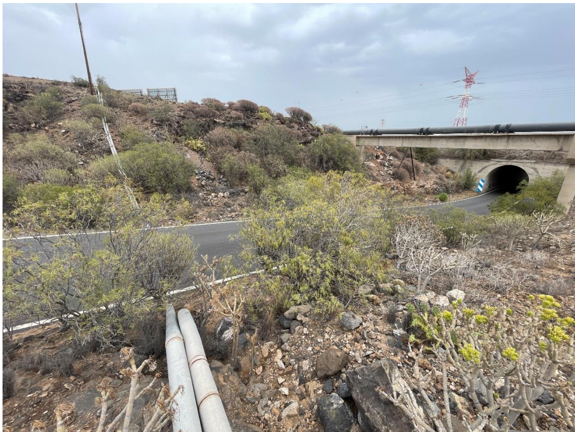
Imagen XXI. Zona prevista de arqueta para by-pass a depósito.
