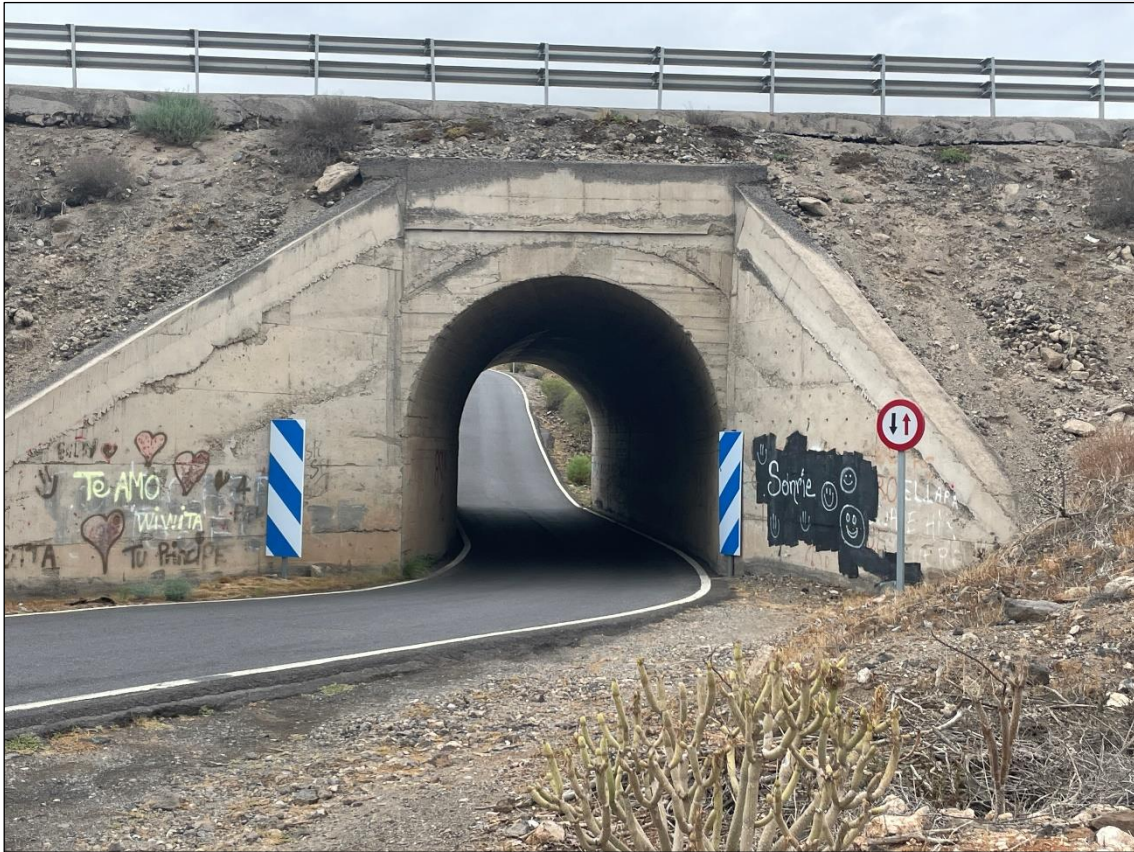
Imagen IV. Estrechamiento por obra de paso en TF-645.
