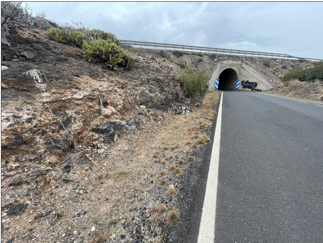
Imagen I. Margen de carretera con tubería de abastecimiento a Los Abrigos con cota -0,80.
