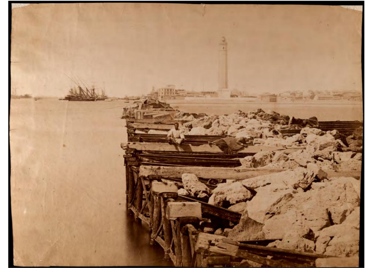
Figura 5. Vista del faro de Port Said y, en primer término, construcción de uno de los espigones del puerto.
