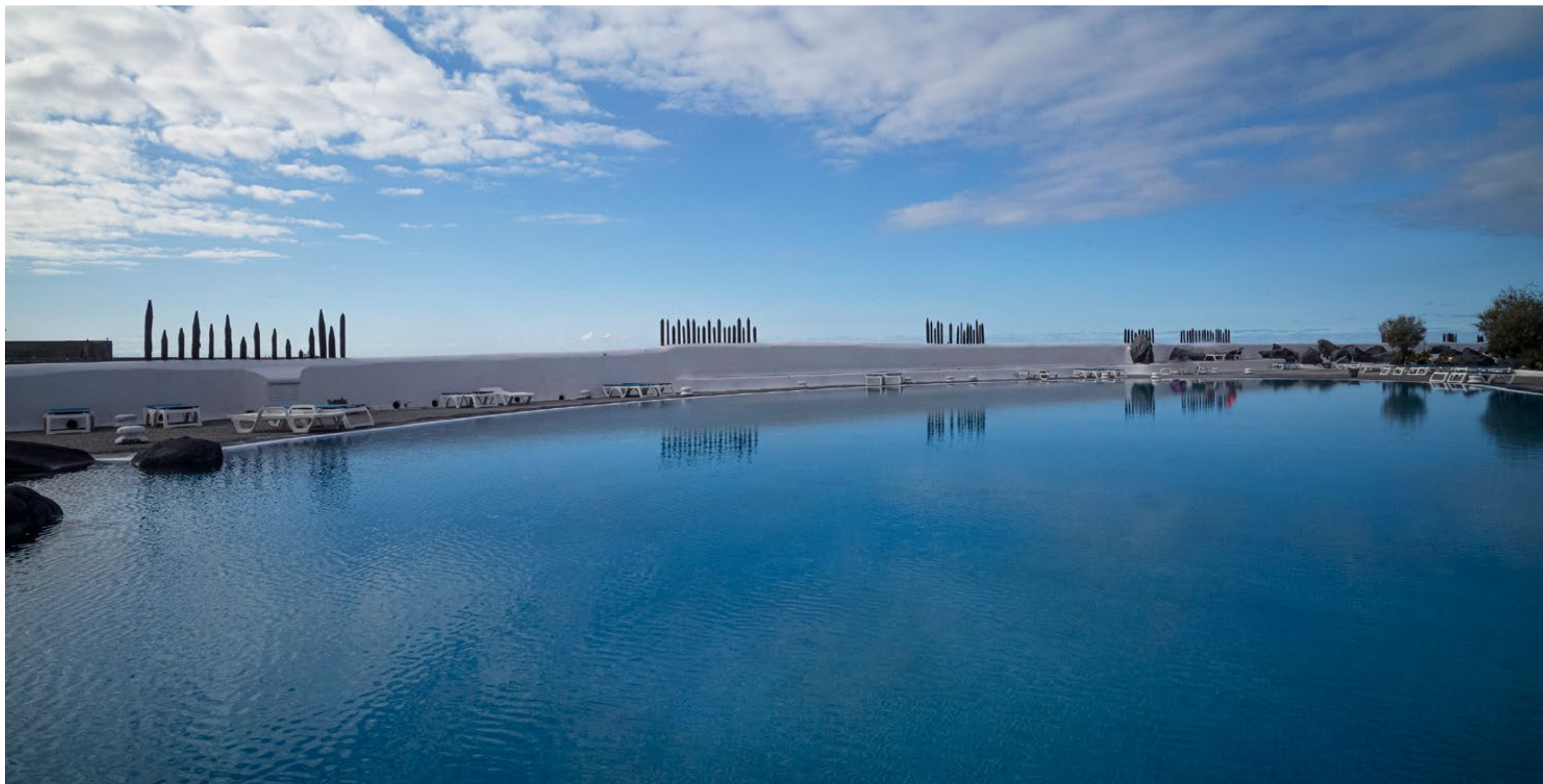
Piscina central de Los Alisios.
