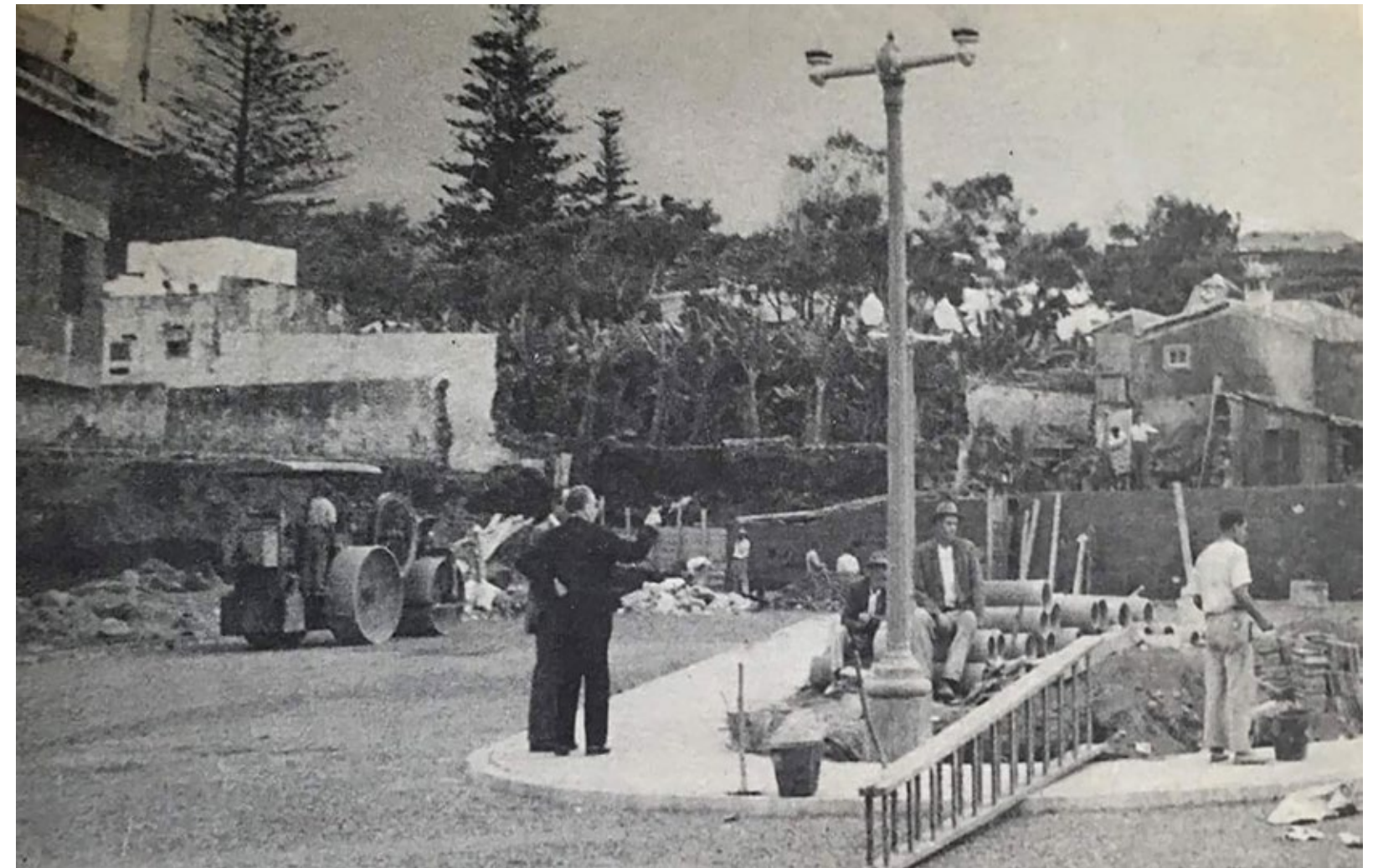
Obras en la Plaza Reyes Católicos y en su entorno, 1956
