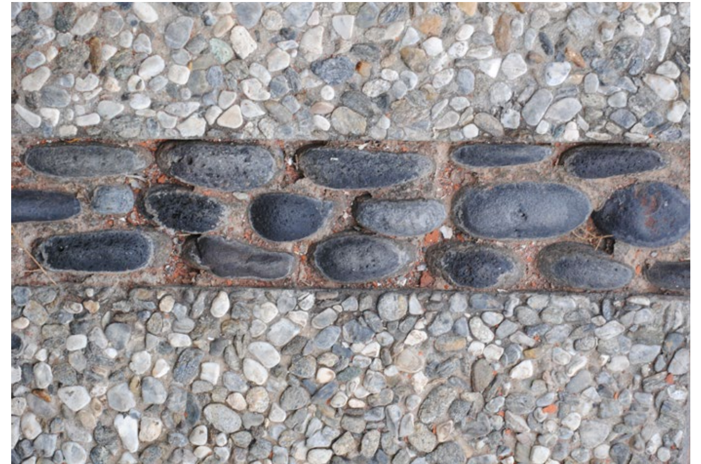
Materiales empleados en el pavimento.
