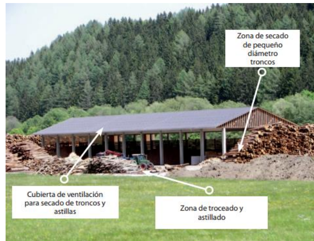
Figura 16. Zona de tratamiento y almacenamiento recurso forestal (Manual de Combustible de madera).
