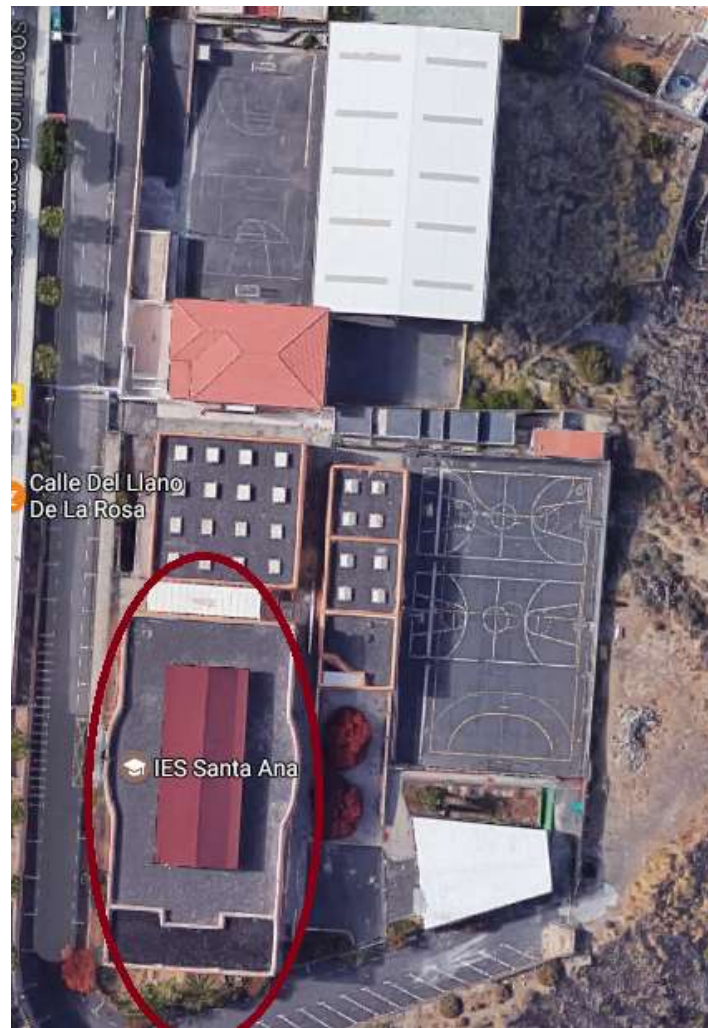
Imagen 5. Situación del edificio donde se encuentra el punto de conexión a la red eléctrica.
