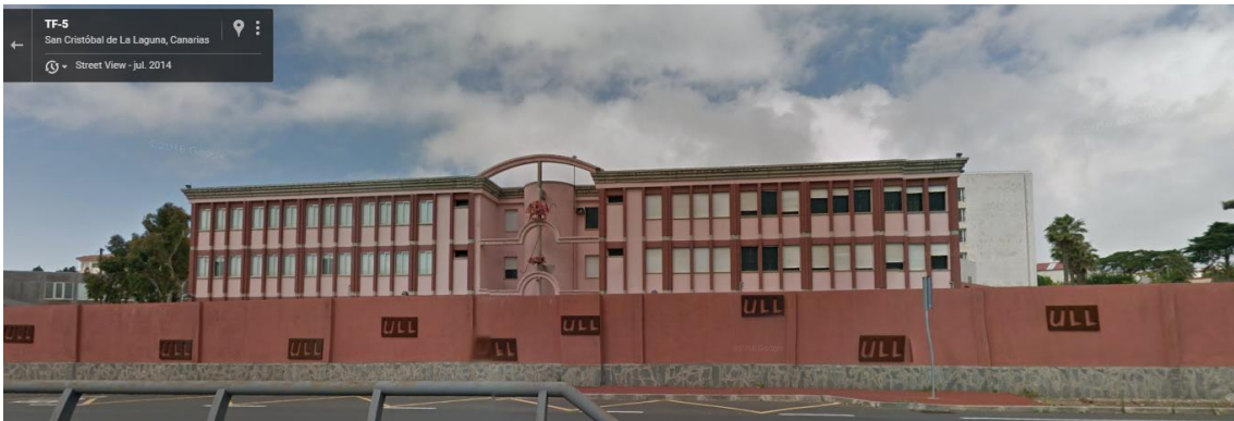
Figura XXIII Edificio calabaza. Fuente https://www.google.es/maps
