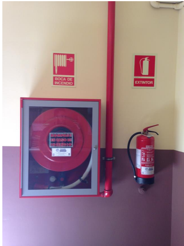
Figura XXV Trabajo de campo (instalación contraincendios) Fuente propia
