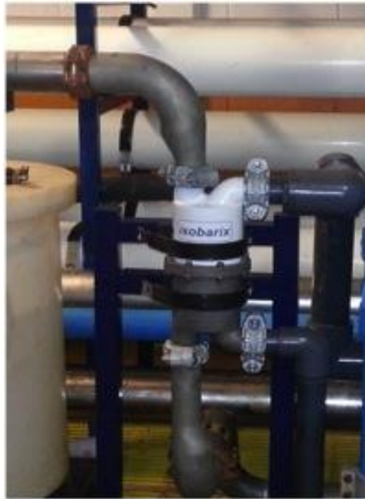
Imagen 23. Recuperador energético Isobarix 509SL en Hotel Oasis Sense en Cancún, México.
