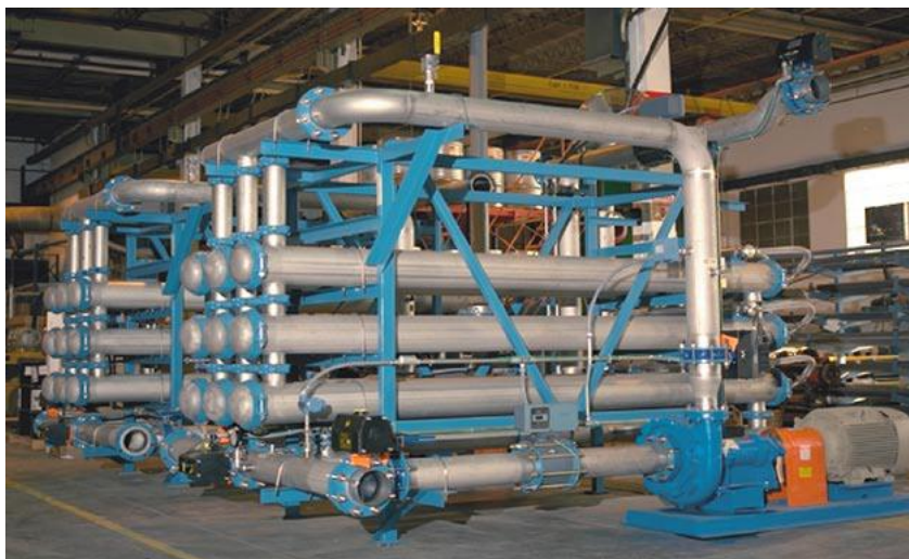
Imagen 37. Ultrafiltración con membrana en espiral
