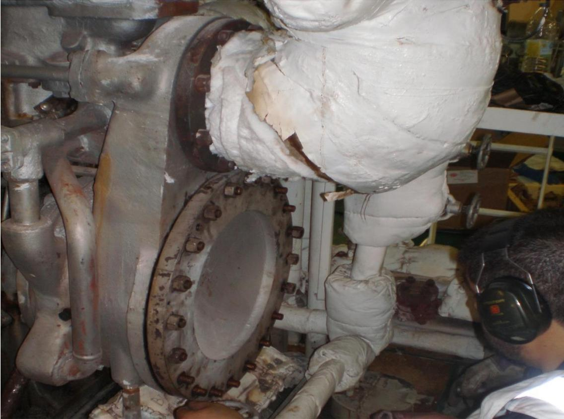
**Ilustración 27.- Tapa de la turbina desferrada. Fuente, Elaboración propia.**
