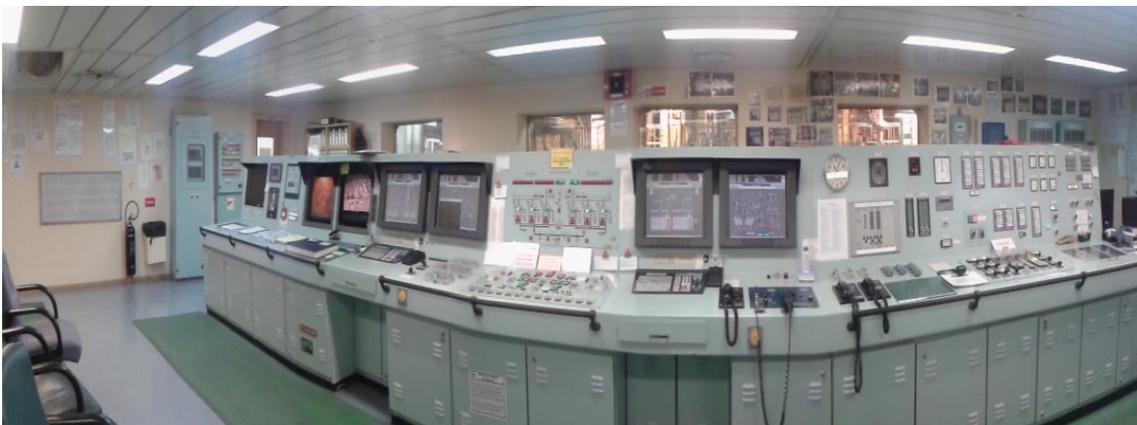
Ilustración 20.- IAS, control de calderas, control de máquinas. Fuente, Elaboración propia.
