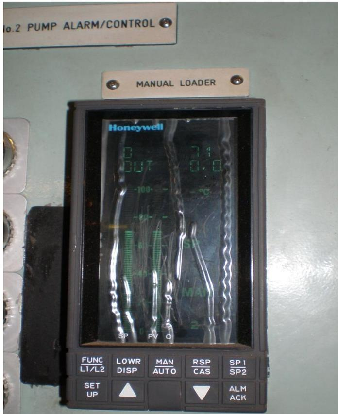
**Ilustración 25.- Controlador Honeywell de carga. Fuente, Elaboración propia.**
