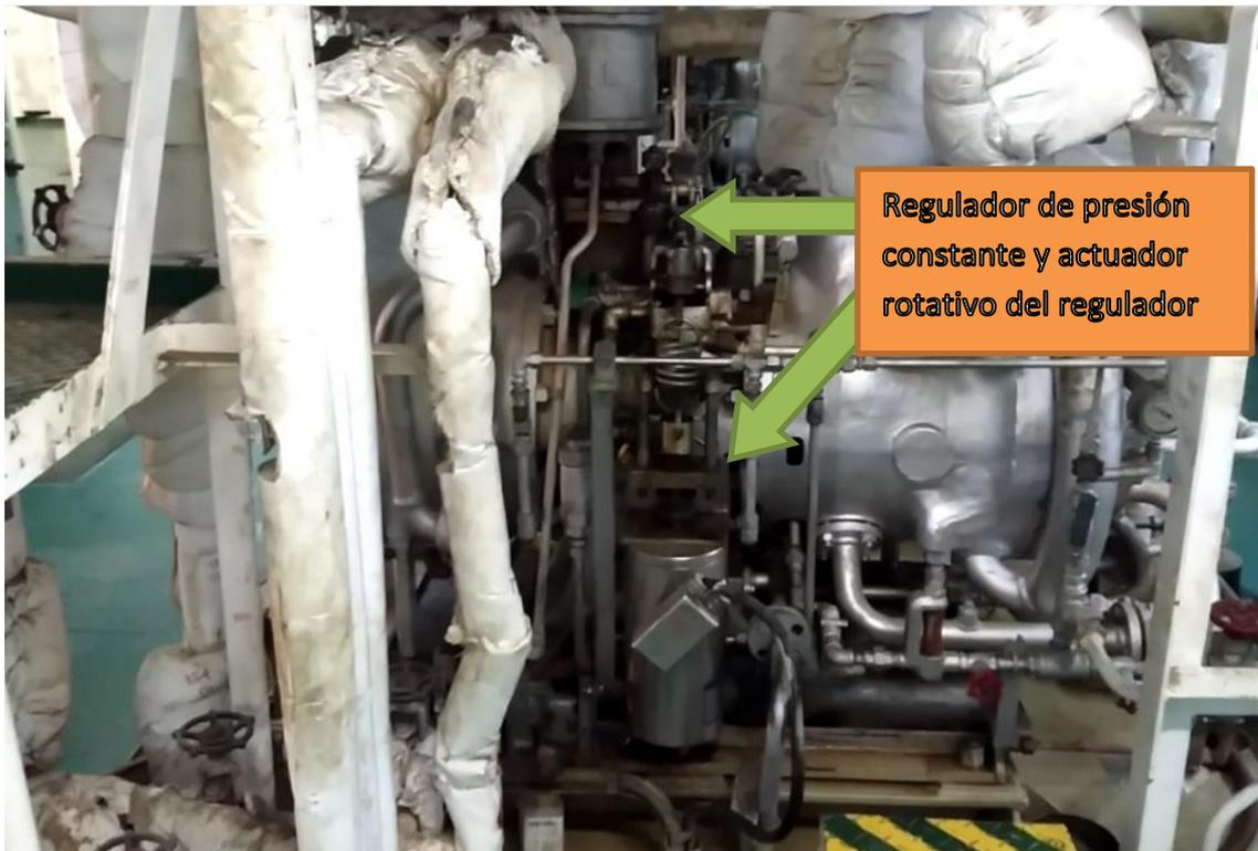
**Ilustración 26.- Detalle regulador de entrada de vapor y actuador. Fuente, Elaboración propia.**
