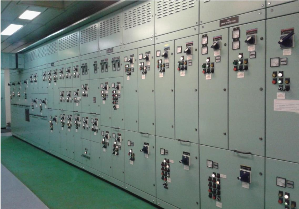
Ilustración 19.- Main Switchboard n°2 . Fuente , Elaboración propia.
