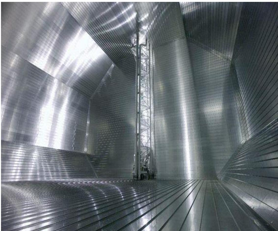
**Ilustración 15.- Interior de un tanque GTT, como se puede apreciar a primera vista no hay diferencias con Gaz Transport no96. Fuente [15]**
