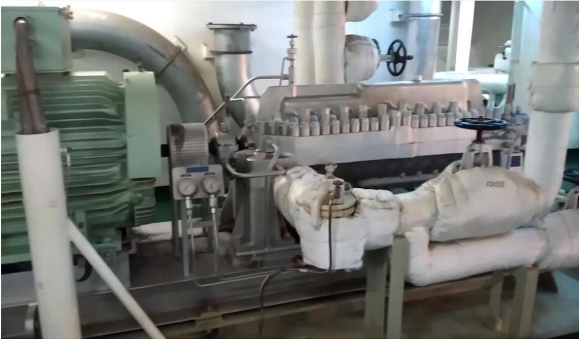
Ilustración 23.- Bomba eléctrica de emergencia Shinko. Fuente, Elaboración propia.
