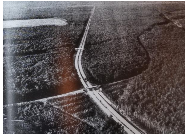
Figura 34: Autopista Frankfurt - Darmstadt
