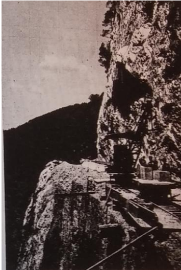
Figura 33: obras en Carreteras alpinas alemanas
