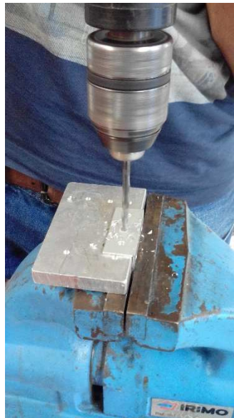
Figura 66. Taladrado del Perfil de unión. Fuente: elaboración propia.
