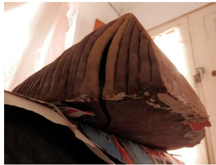
Figura IV.26. Grieta en la placa base que provoca la separación de los colombines.
