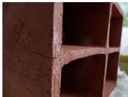
Figura IV.75. Grieta producida en la caja tabicada que se aprecia en el exterior.
