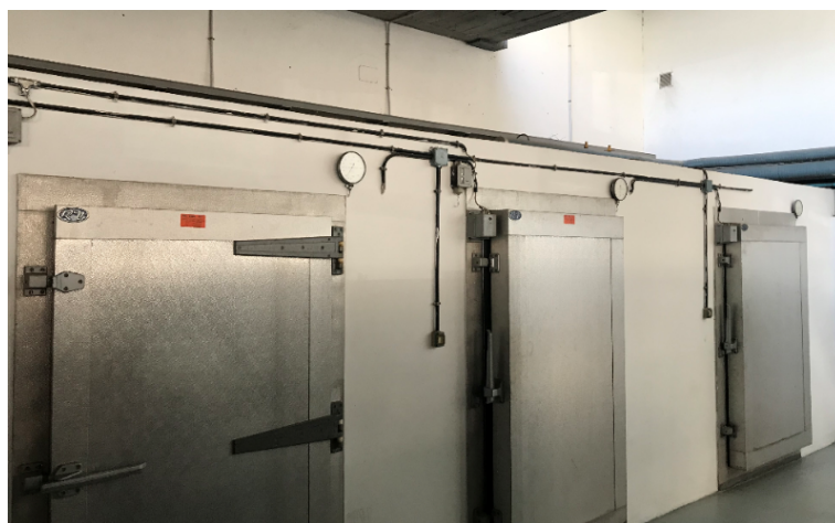
Figura 1.5: Cámaras del aula - taller Fuente: Elaboración propia
