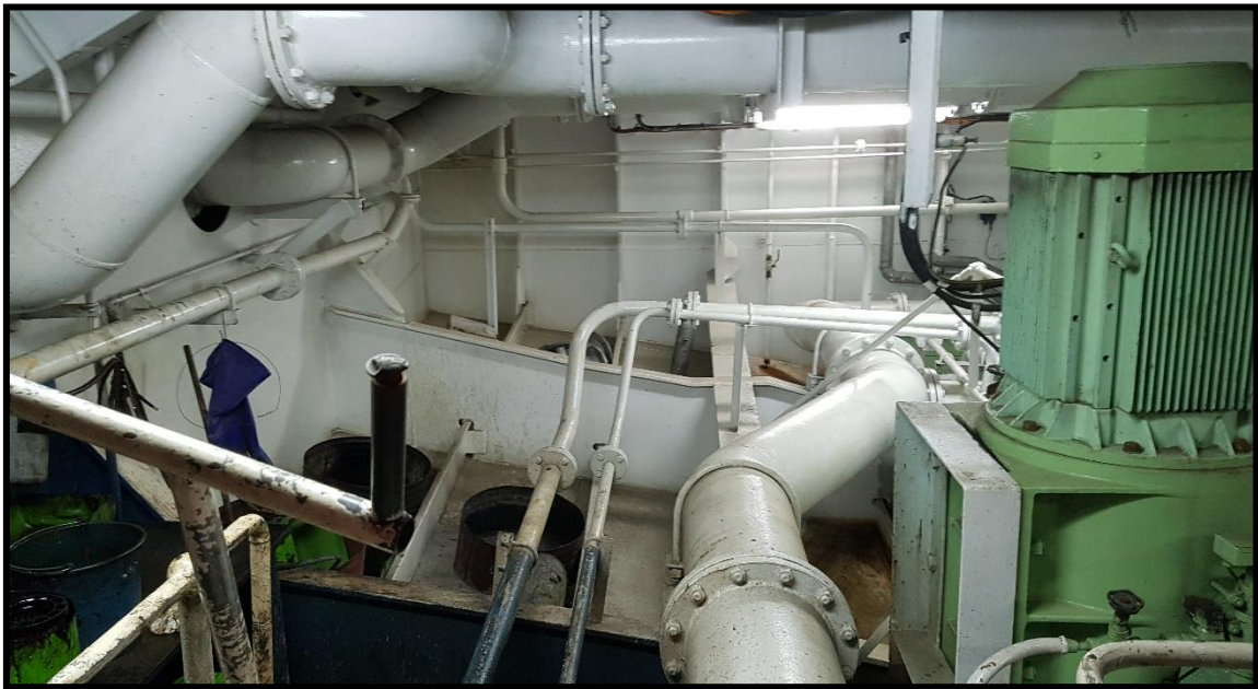
Ilustración N°38: Espacio disponible, dentro de la cámara de bombas.
