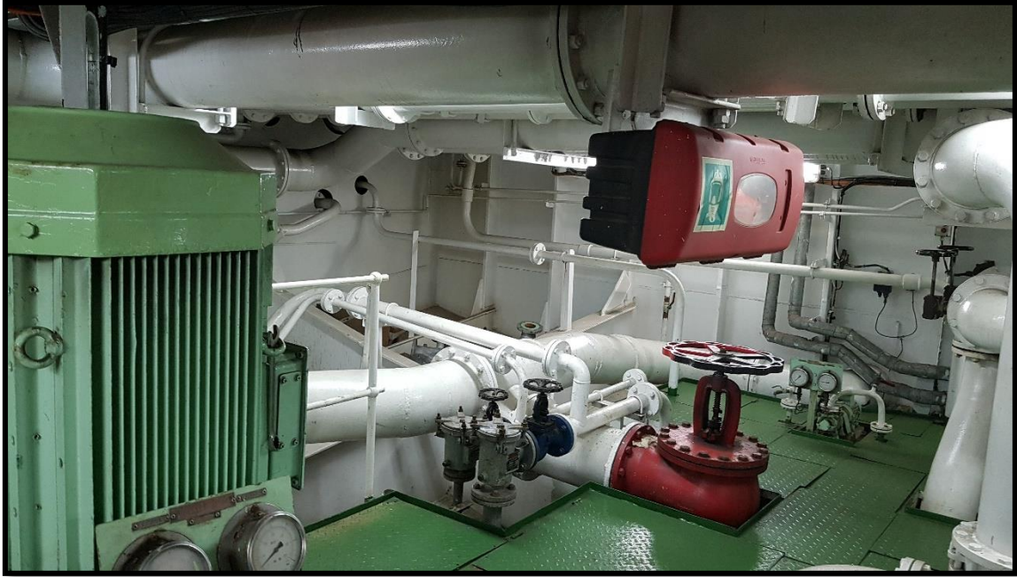
Ilustración N°39. Espacio disponible, dentro de la cámara de bombas.
