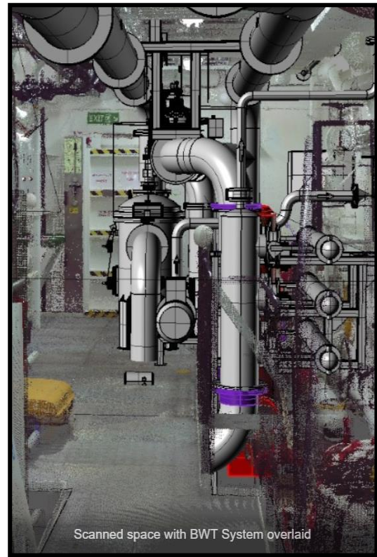
Ilustraciones Nº35. Ejemplo de escaneado 3D de una sala de máquinas, y superposición del sistema.
