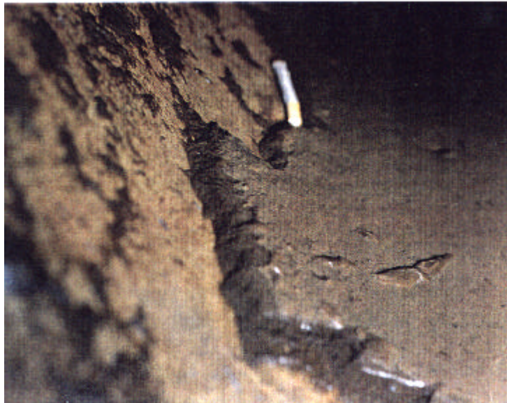
Detalle de la película biológica del interior de la conducción
