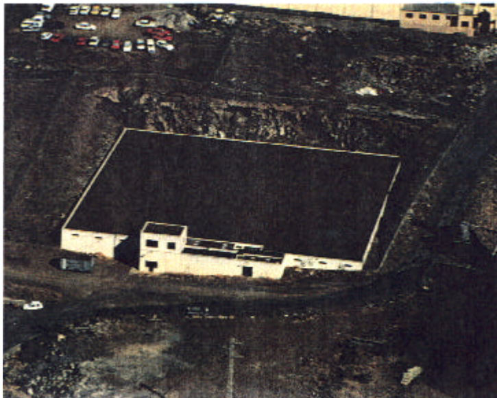
Vista aérea del Depósito Regulador de El Tablero
