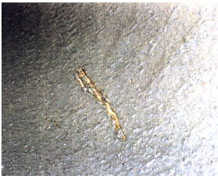
Detalle de la película biológica del interior de la conducción
