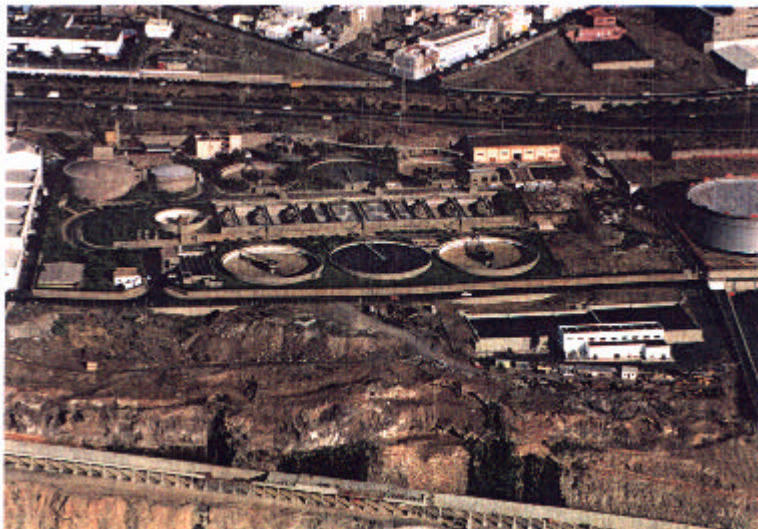
Vista aérea de la EDAR y de la Estación de Bombeo
