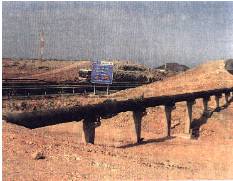
Vista parcial de la Conducción de Transporte
