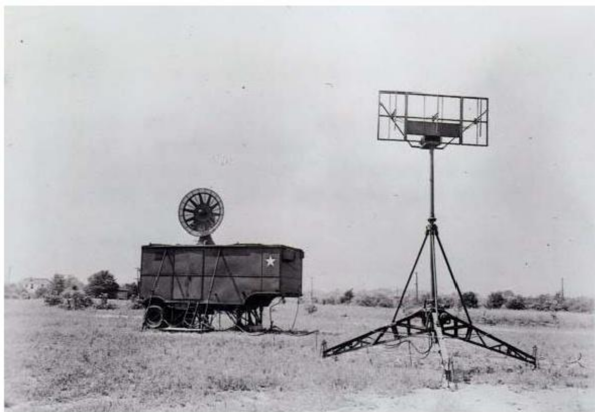
Foto nº. 66. Un radar americano de dirección de tiro de cañones antiaéreos SCR-584 junto con una antena de IFF (a la derecha).
