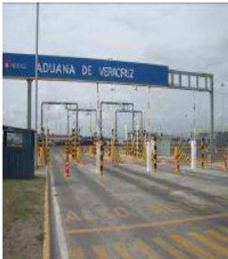
Foto n°.29.Arco Megaport. FUENTE:AEAT. Departamento de Aduanas e IIEE.
