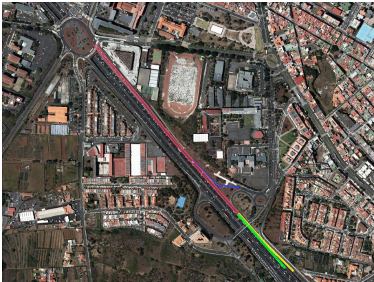
(a) La salida de la TF-5 (dir. norte) a la rotonda de Padre Anchieta vista desde lejos.
