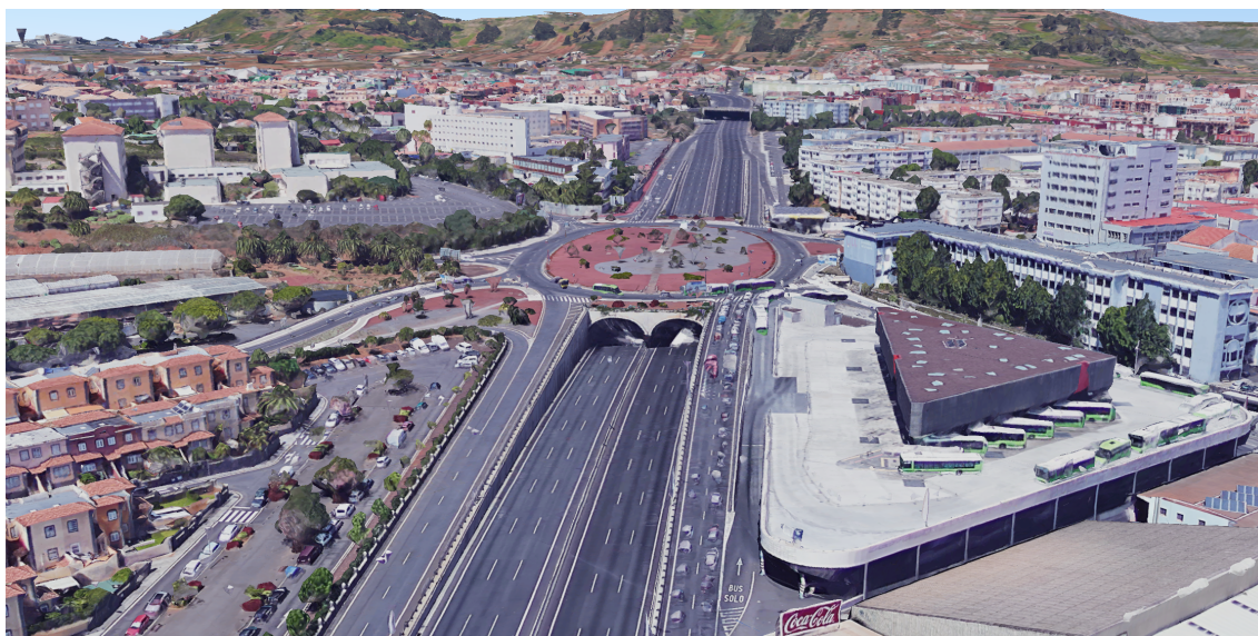
Figura 1.1: Mapeado en 3D de la Rotonda del Padre Anchieta. Cortesía de Google Earth 1
