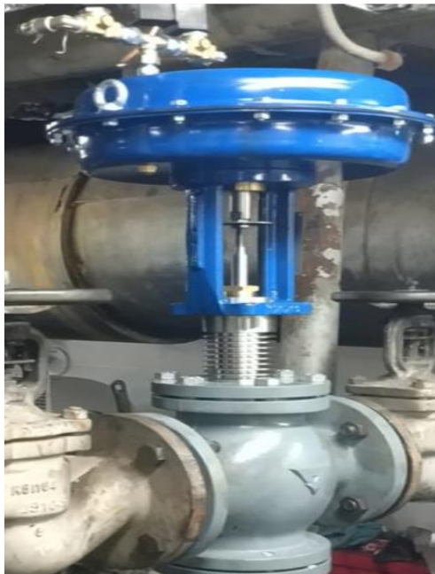
Ilustración 28. Válvula de 2 vías accionamiento neumático. Fuente: Trabajo de Campo.
