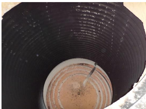
Ilustración 22. Hogar Sucio. Fuente: Trabajo de campo.
