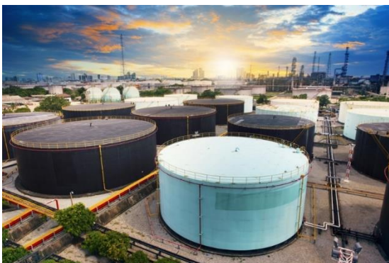
Ilustración 3. Calentamiento de tanques mediante AT. Fuente [14]
