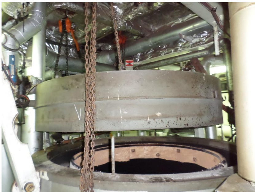
Ilustración 21. Desmote de tapa de caldera. Fuente Trabajo de Campo
