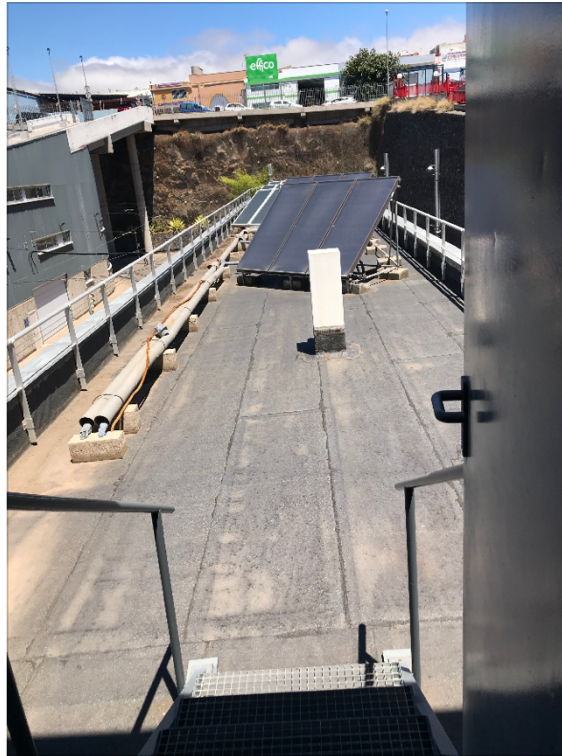
Figura 85. Vista desde la puerta del almacén hacia la cubierta.
