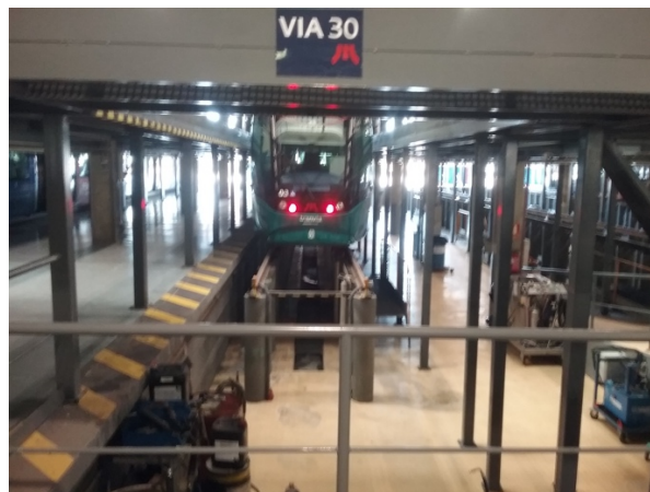
Figura 77. Línea de tranvía 30. Pilares de apoyo retranqueados.
