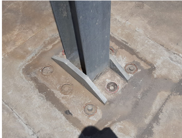
Figura 79. Pilar HEB tipo. Zona exterior Noroeste.
