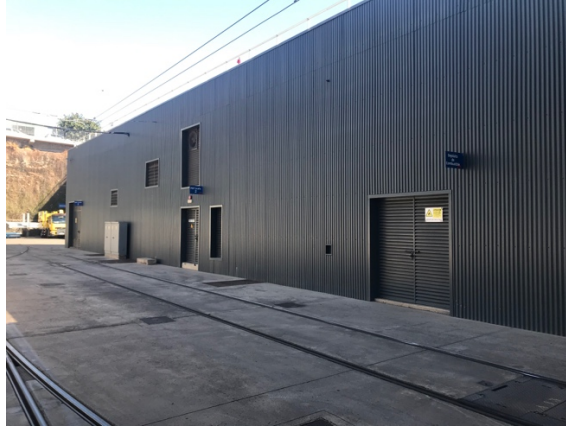
Figura 84. Fachada edificio de vigilancia y almacenaje.
