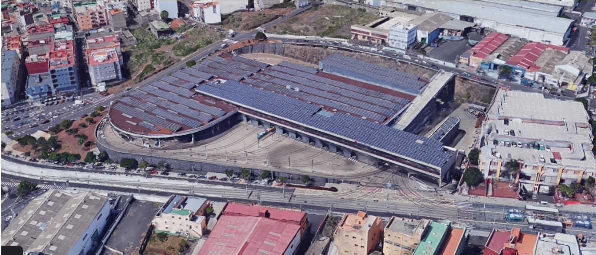
Figura 25. Edificio de Talleres y Cocheras del Metro de Tenerife. Fuente: Google Earth
