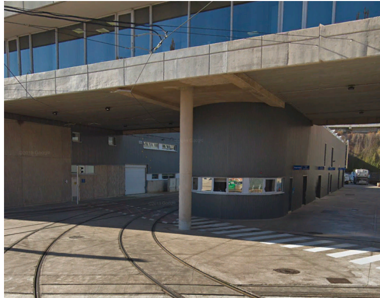
Figura 68. Vista exterior desde el acceso a la edificación.
