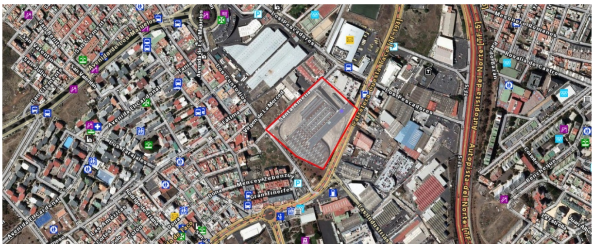
Figura 24. Plano de Emplazamiento y Localización del Edificio de Talleres y Cocheras del Metro de Tenerife.
