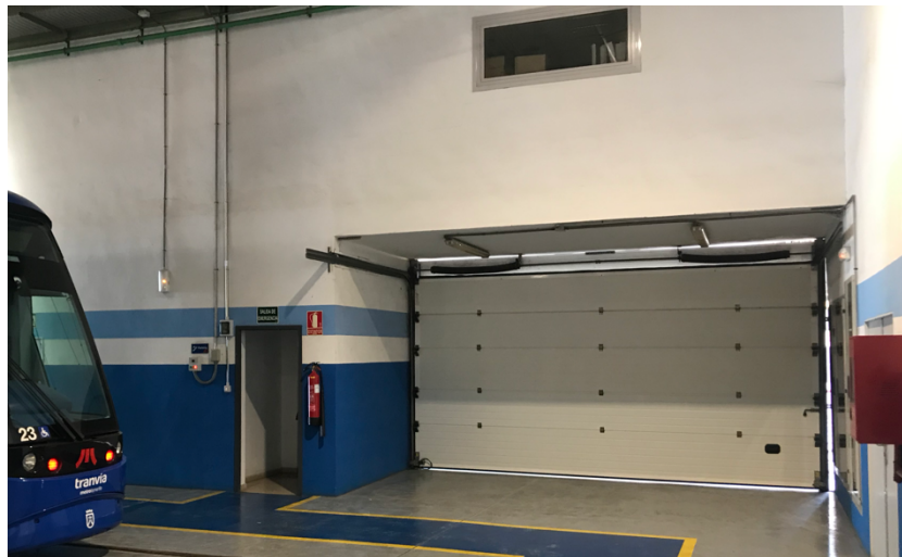
Figura 89. Puerta de Garaje de Planta Baja.
