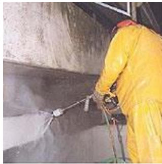
Figura nº 44. Operario con agua alta presión.
