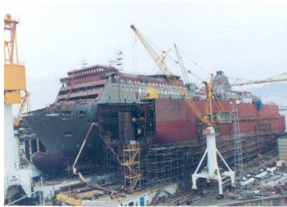
Figura nº 46. Construcción en astillero.
