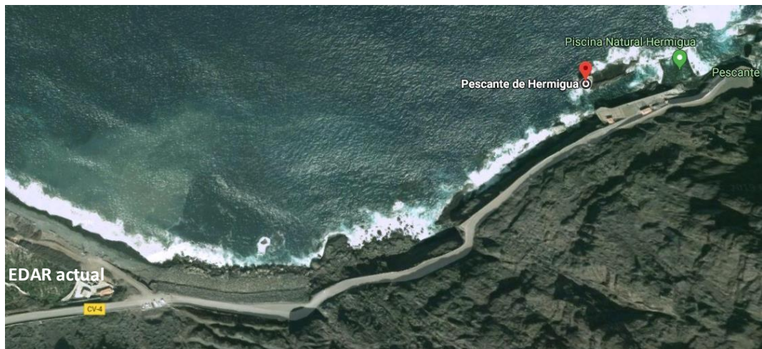
Figura 4.1. Distancia entre la EDAR y Pescante de Hermigua. (Google Maps)
