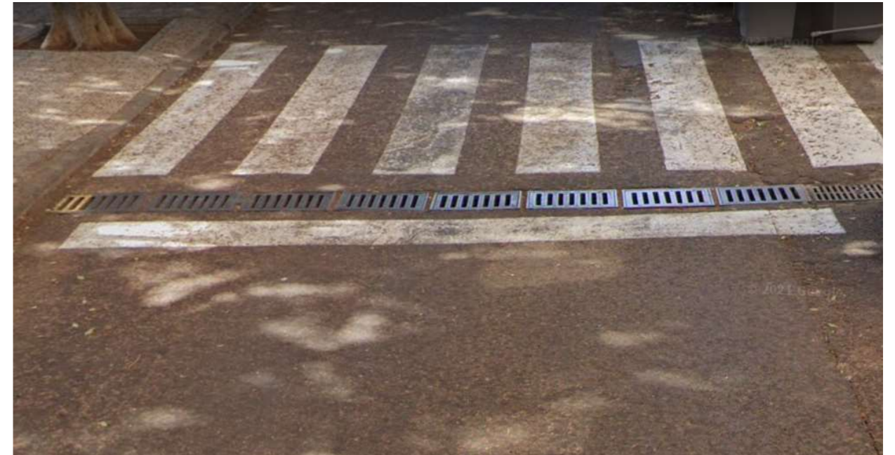
Figura 6. Detalle drenaje superficial calle Punta de Anaga. Fuente: Visor Grafcan
