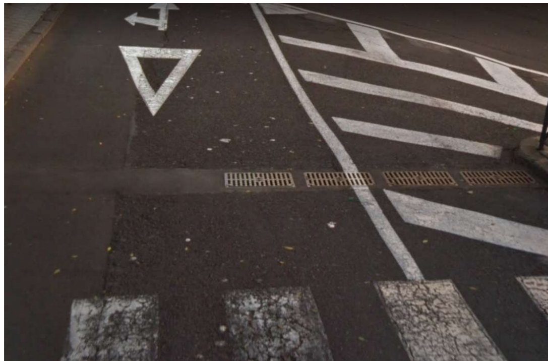
Figura 5. Detalle drenaje superficial calle Punta de Anaga. Fuente: Visor Grafcan
