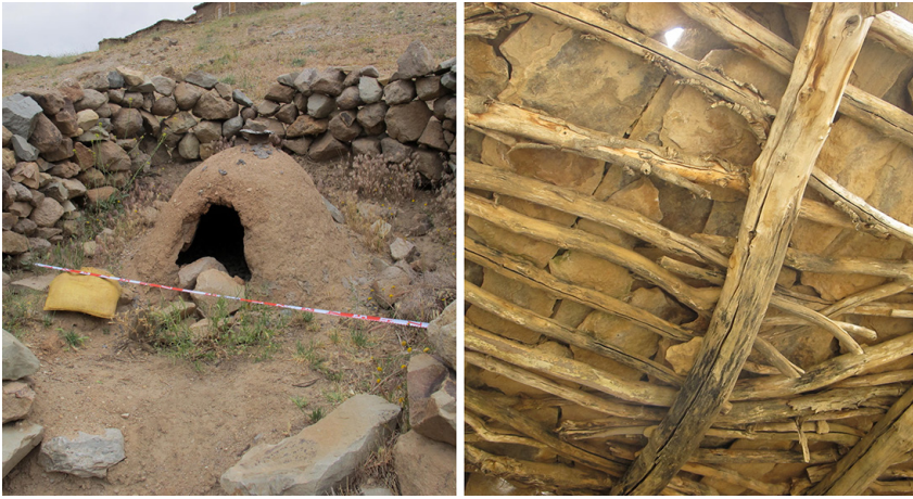
Figura 4. Caso de horno colectivo (izquierda) y de techo con estructura de madera (derecha) en el azib de Tiquirit.
