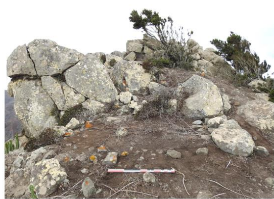
Derrumbe y presencia de suelo antrópico
