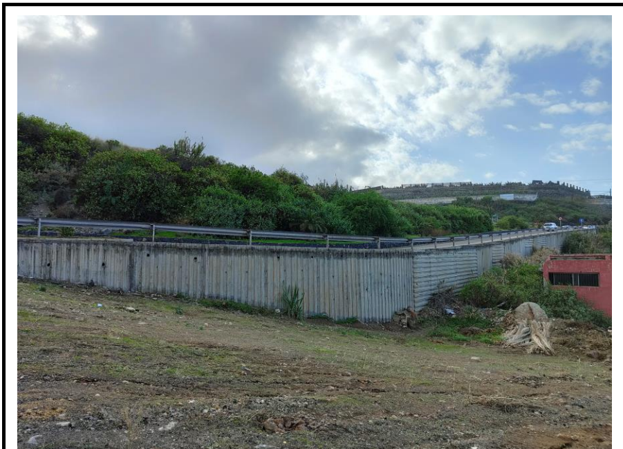
FOTOGRAFÍA 8.- MURO DE CONTENCIÓN DONDE IRÁ ANCLADA LA TUBERÍA EBAR SAN JUAN DE LA RAMBLA II - EDAR SAN JUAN DE LA RAMBLA
