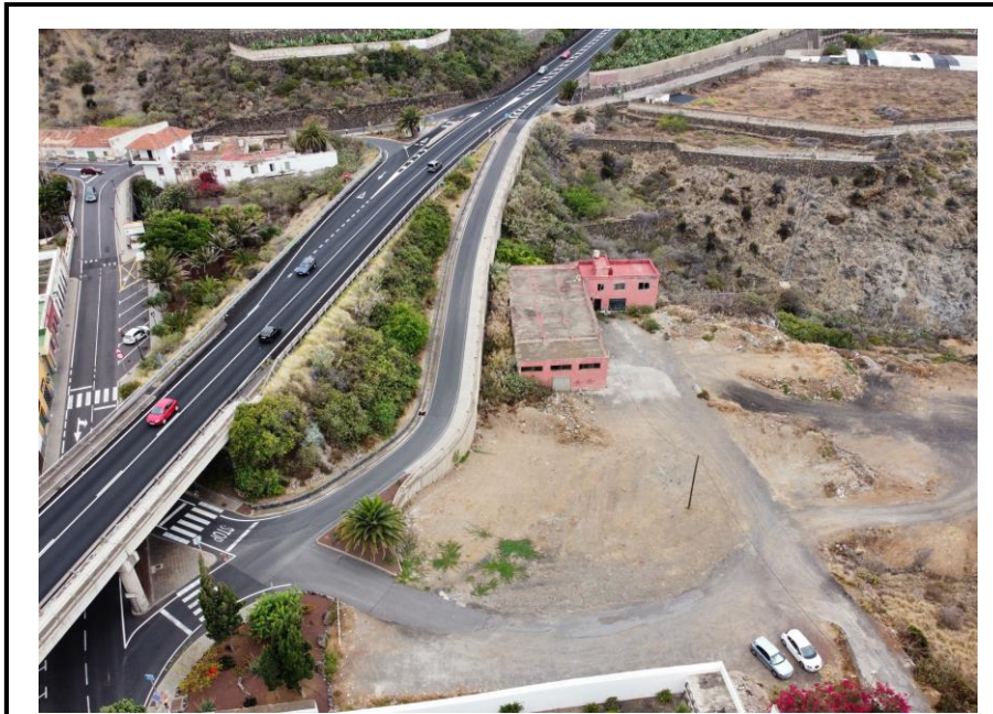
FOTOGRAFÍA 7.- VISTA AÉREA DEL TRAZADO POR EL QUE DISCURRIRÁ LA TUBERÍA EBAR SAN JUAN DE LA RAMBLA II - EDAR SAN JUAN DE LA RAMBLA
