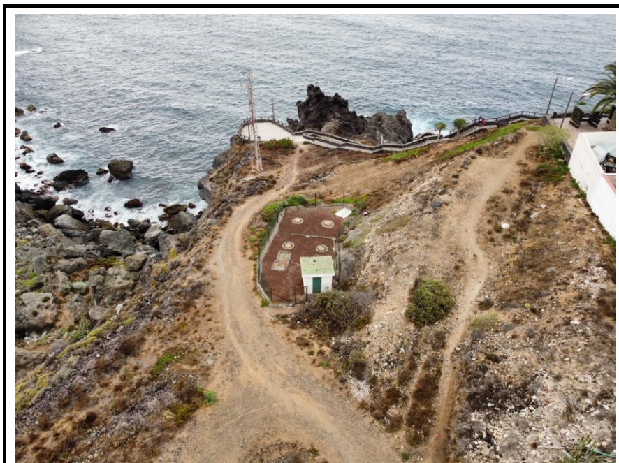
FOTOGRAFÍA 1.- VISTA AÉREA MEDIANTE DRON EBAR SAN JUAN DE LA RAMBLA I
