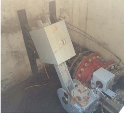
Figura 4.2: Vista de una Válvula de Seguridad
