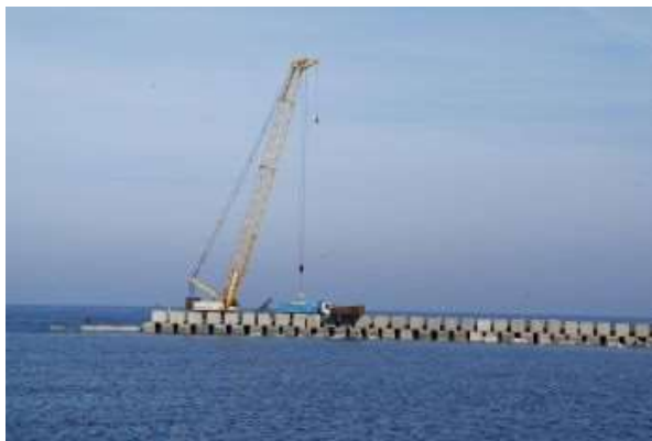
Ilustración 23. Construcción dique de protección. Fuente: http://www.cronicasdelanzarote.es/Las-obras-de-ampliacion-del-puerto.html
