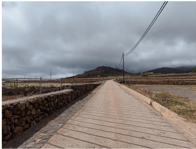
Imagen 4: Camino acceso pavimentado.
