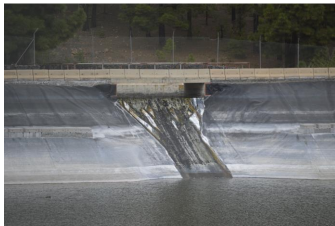
Imagen 27: Obra de entrada.
