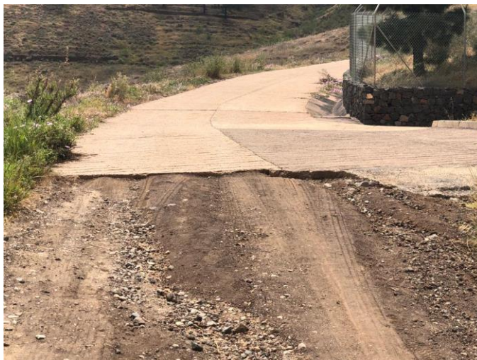
Imagen 17: Cambio zona no pavimentada a pavimentada.
