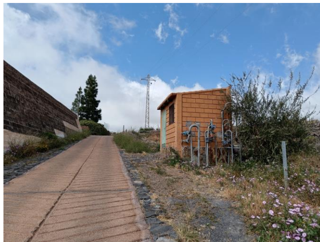
Imagen 2: Caseta de válvulas 1.
