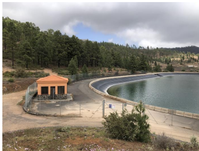
Imagen 24: Caseta de control.
