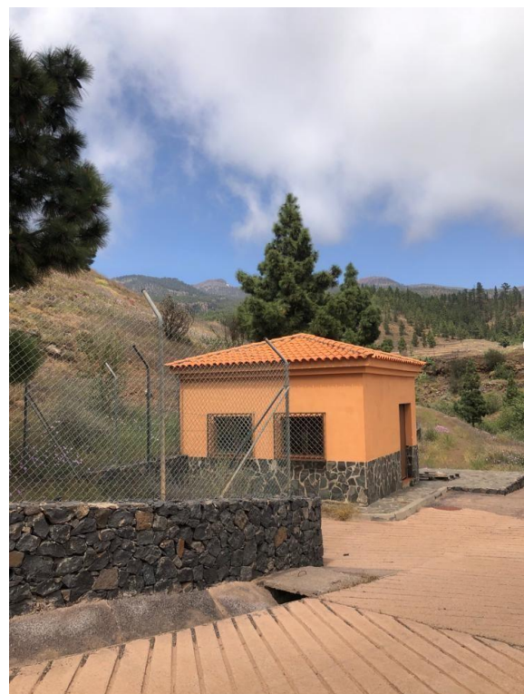
Imagen 19: Caseta de control.
