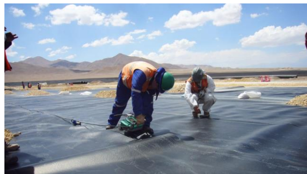
Imagen 7: Realización de soldadura
