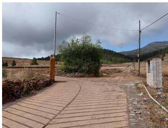
Imagen 11: Cruce de acceso a la Balsa de Trevejos.
