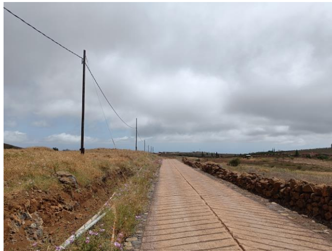
Imagen 10: Camino de acceso pavimentado.
