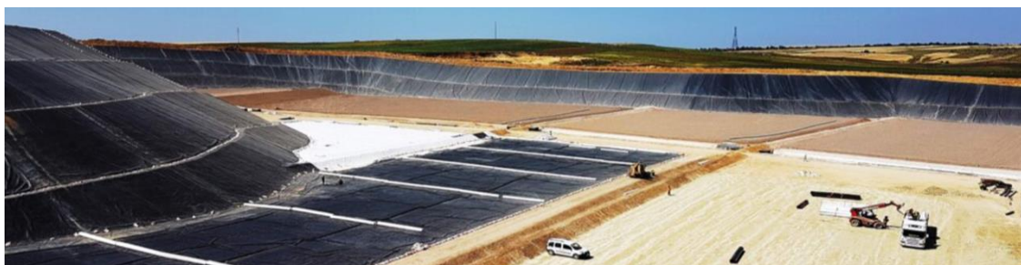
Imagen 5: Instalación de lamina
