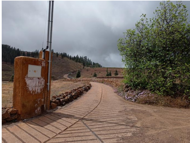
Imagen 12: Acceso a la Balsa Trevejos.
