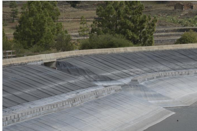
Imagen 26: Berma superior y anclajes.
