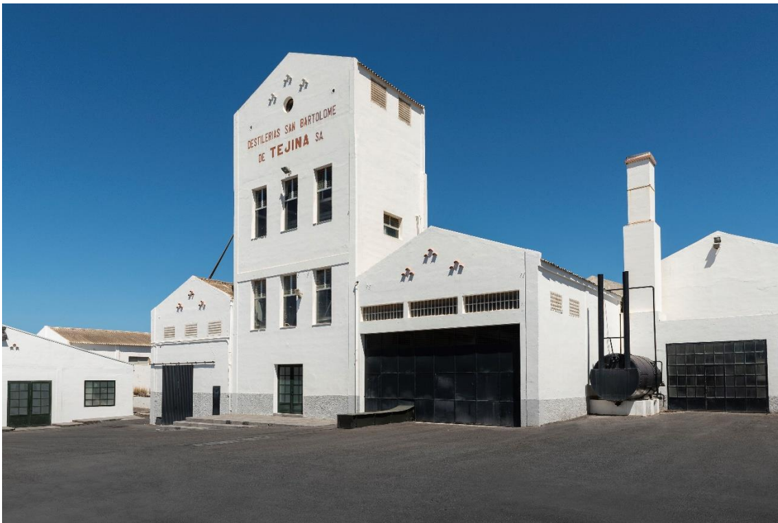
Ilustración 1. Fachada principal Destilería de San Bartolomé de Tejina en la actualidad. (Fondo documental de Destilerías San Bartolomé de Tejina, S.A.).
