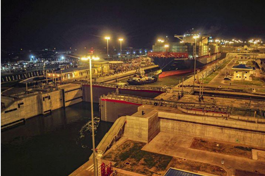
Ilustración 33. Compuertas de la ampliación del Canal – Fuente: https://www.scidev.net/america-latina/news/valoran-pago-por-servicios-ambientales-en-elcanal-de-panama/
