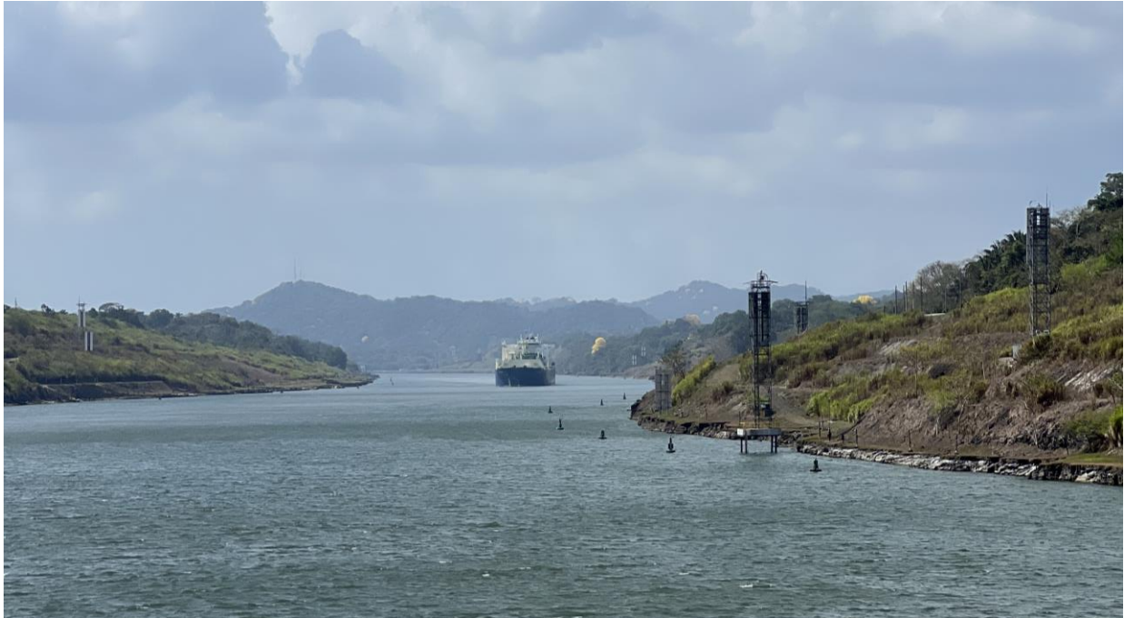
Ilustración 20. Tableros de enfilación y boyas limitantes del canal - Fuente: Trabajo de campo.
